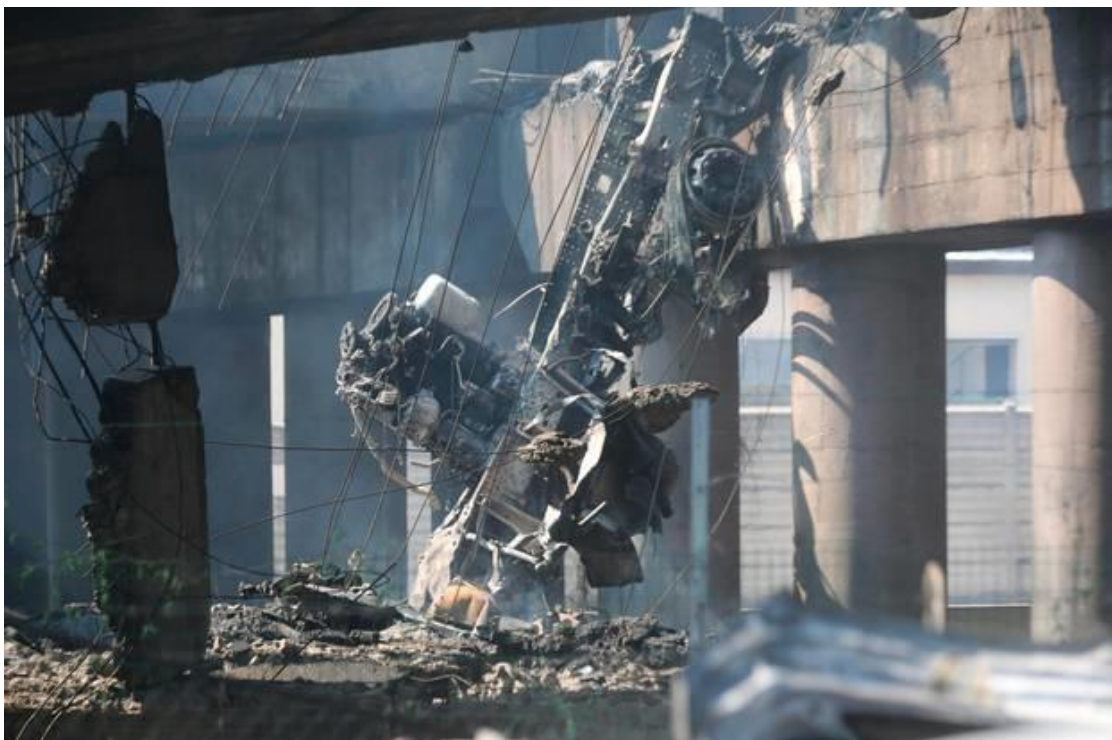
Εικόνα 5.10. Το κατεστραμμένο βυτιοφόρο μεταφοράς LPG (driven, 2018).
