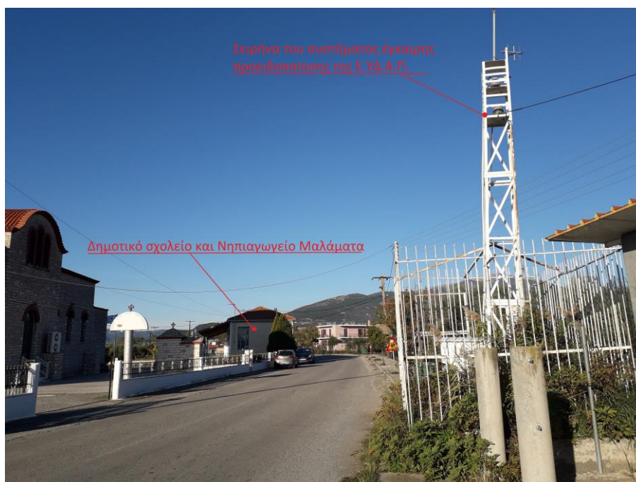
Εικόνα 4.11: Η σειρήνα του συστήματος έγκαιρης προειδοποίησης πληθυσμού της ΕΥΔΑΠ που βρίσκεται στα Μαλάματα.
