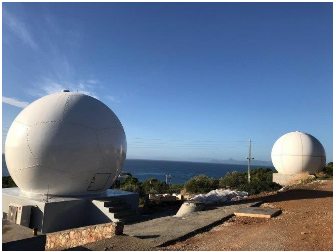
Εικόνα 2.5: Δορυφορικός Σταθμός EUMETSAT-EMY (Αθήνα – 128ΣΕΤΗ/Καβούρι)
