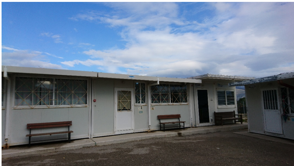
Εικόνες 80-81-82: 2 ο Δημοτικό Σχολείο Ληξουρίου προσωρινή στέγαση σε προκατασκευασμένες αίθουσες, σε χώρο δίπλα στο ΕΠΑΛ Ληξουρίου 1 ος /2020 (Προσωπικό Αρχείο Κούτμου, 2020)
