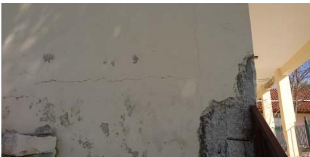
Εικόνες 96-97: Νηπιαγωγείο Αμπελοκήπων – βλάβες από το σεισμό του 2018. Έρευνα 2 ος /2020 (Προσωπικό Αρχείο Κούτμου, 2020)
