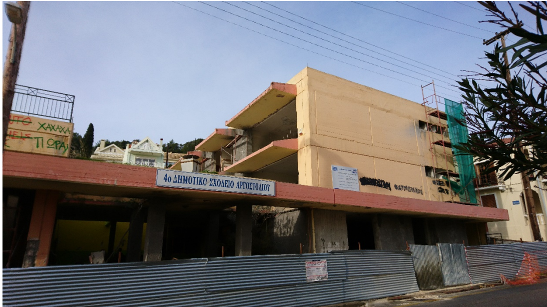
Εικόνα 22 : 4 ο Δημοτικό Σχολείο Αργοστολίου σε εξέλιξη επισκευών 1 ος /2020 (Προσωπικό Αρχείο Κούτμου, 2020)
