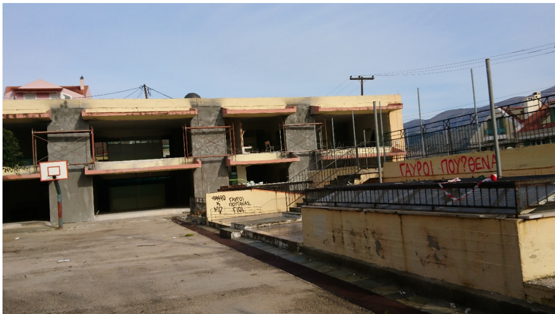
Εικόνα 23 : 4 ο Δημοτικό Σχολείο Αργοστολίου σε εξέλιξη επισκευών 1 ος /2020 (Προσωπικό Αρχείο Κούτμου, 2020)
