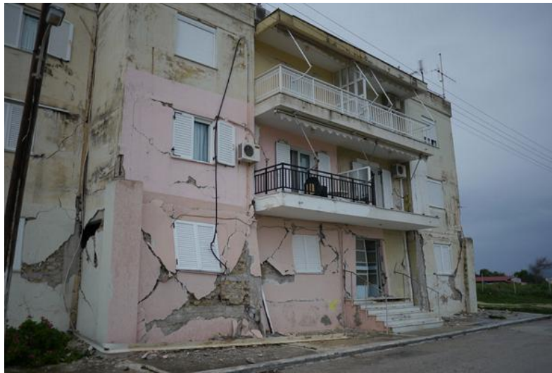
Εικόνα 13: Βλάβες στις Εργατικές Κατοικίες Ληξουρίου (Euronews, 2014)
