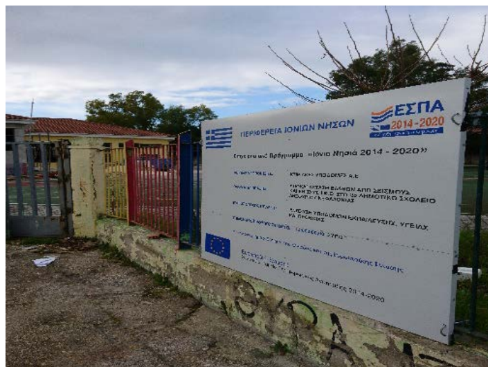
Εικόνες 74-75: 2 ο Δημοτικό Σχολείο Ληξουρίου σε εξέλιξη επισκευών 1 ος /2020 (Προσωπικό Αρχείο Κούτμου, 2020)
