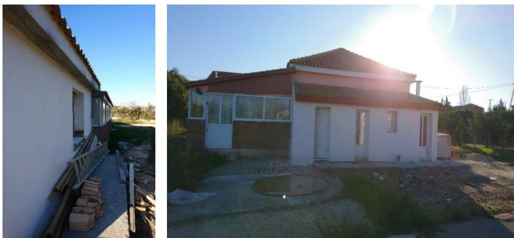
Εικόνες 19-20 : Νηπιαγωγείο Λακήθρας σε εξέλιξη επισκευών 1 ος /2020 (Προσωπικό Αρχείο Κούτμου, 2020)
