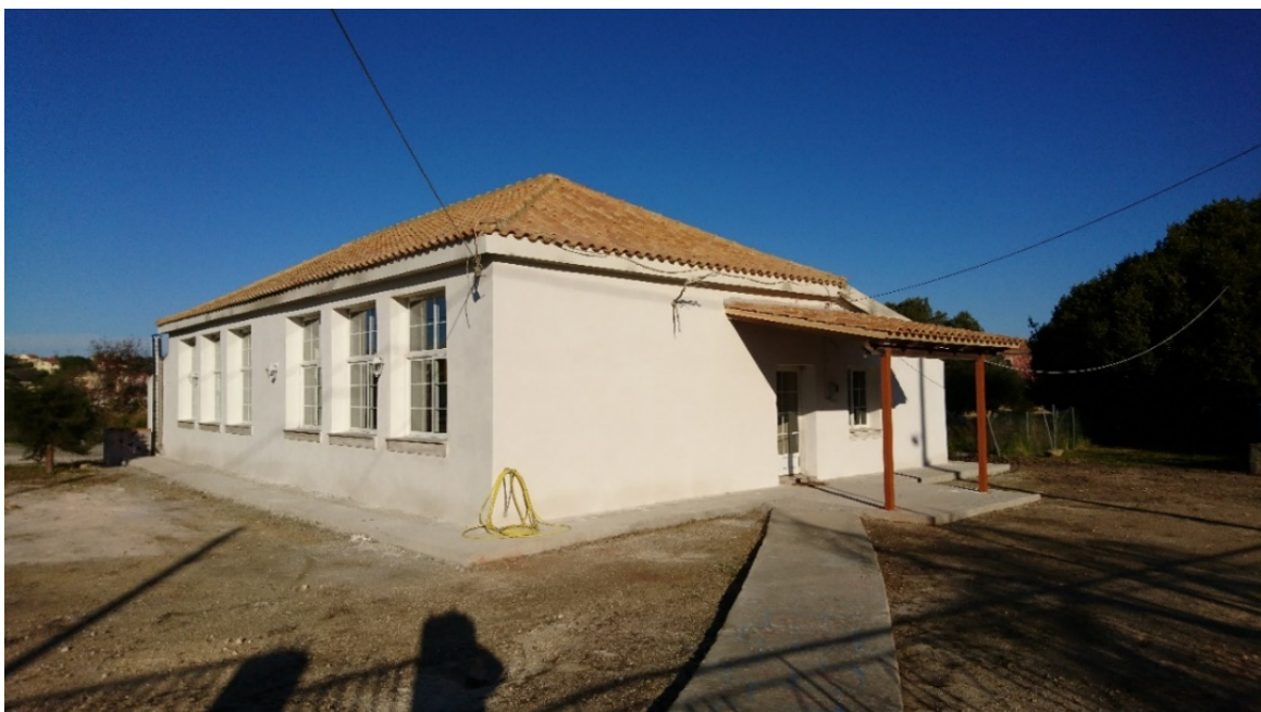
Εικόνα 18 : Νηπιαγωγείο Λακίθρας σε εξέλιξη επισκευών 1 ος /2020 (Προσωπικό Αρχείο Κούτμου, 2020)
