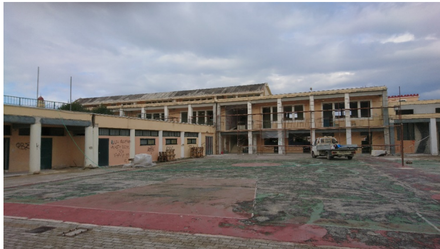
Εικόνα 47: Γενικό Λύκειο Ληξουρίου σε εξέλιξη επισκευών 1 ος /2020 (Προσωπικό Αρχείο Κούτμου, 2020)
