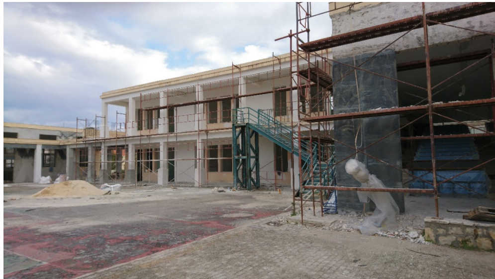
Εικόνες 41-42-43: Πετρίτσειο Γυμνάσιο Ληξουρίου σε εξέλιξη επισκευών 1 ος /2020 (Προσωπικό Αρχείο Κούτμου, 2020)
