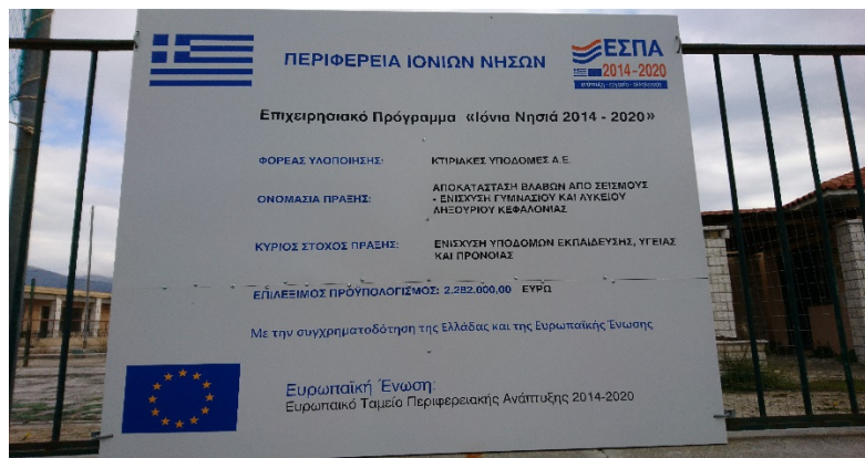
Εικόνες 38-39-40: Πετρίτσειο Γυμνάσιο Ληξουρίου σε εξέλιξη επισκευών 1 ος /2020 (Προσωπικό Αρχείο Κούτμου, 2020)
