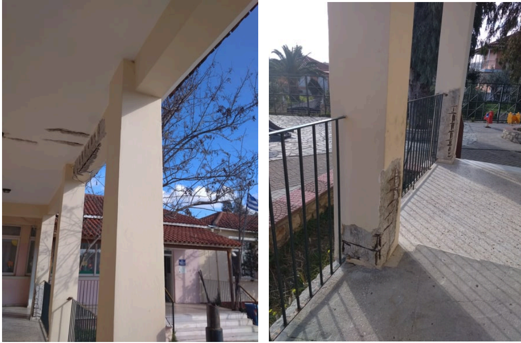
Εικόνες 92-93: Νηπιαγωγείο & Δημοτικό Σχολείο Αμπελοκήπων – βλάβες από το σεισμό του 2018. Έρευνα 2 ος /2020 (Προσωπικό Αρχείο Κούτμου, 2020)
