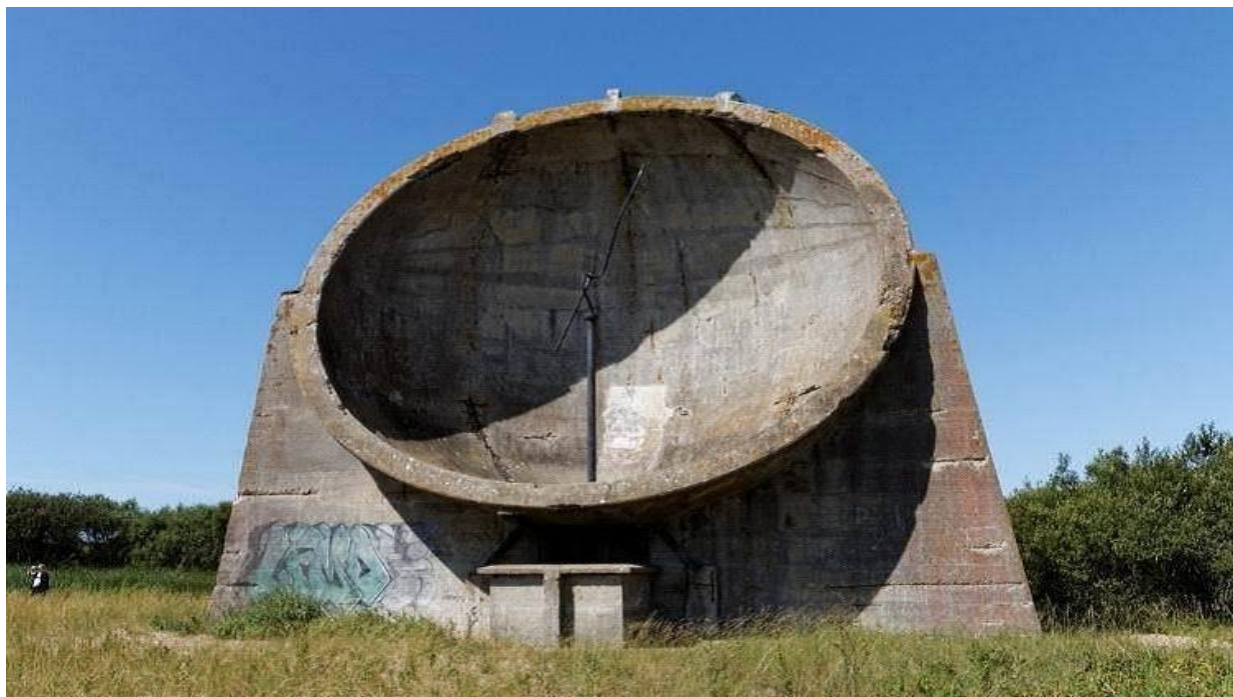
Εικόνα 2.9 Συλλέκτης ήχου. Αποτελέσει το κύριο σύστημα εντοπισμού και έγκαιρης προειδοποίησης κατά την διάρκεια του μεσοπολέμου τα οποία αναπτύχθηκαν κυρίως στην Νότια πλευρά της Μεγάλης Βρετανίας. x
