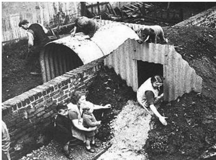
Εικόνα 2.5 Καταφύγιο Άντερσον. Απαιτούνταν η τοποθέτηση του εντός του εδάφους σε βάθος ενός (1) μέτρου περίπου. Εδώ βρίσκεται σε εξέλιξη η εγκατάσταση του σε αυλές σπιτιών. VI
