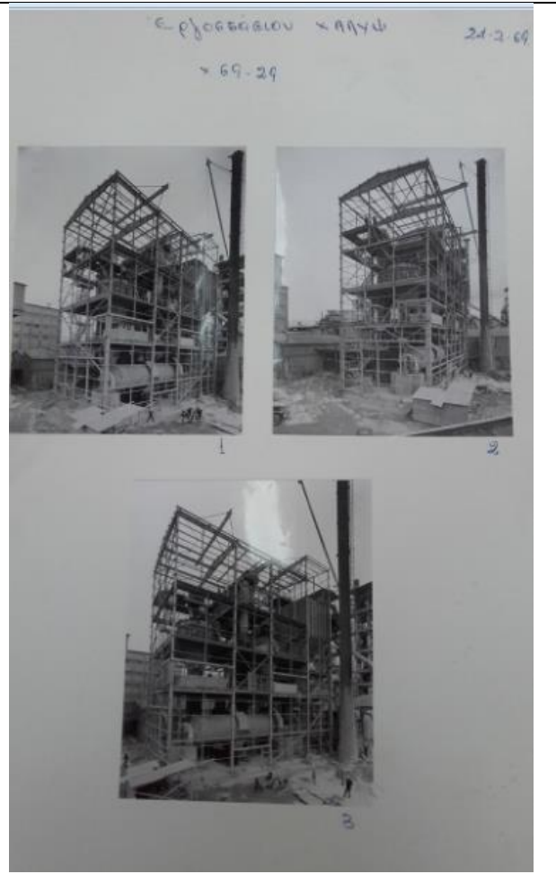
Εργοστάσιο Τσιμέντων «ΧΑΛΥΨ», 1969
