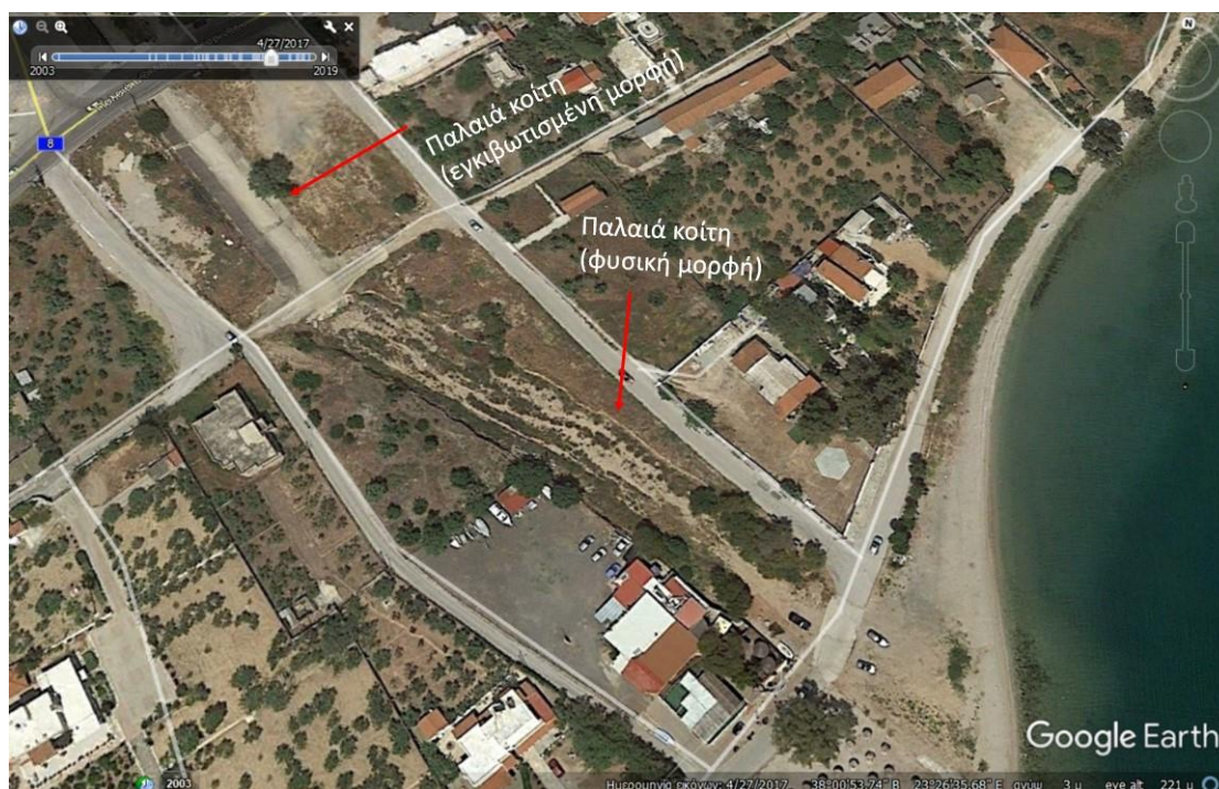
Εικόνα 2.3.6.1 : Τα όρια της κοίτης του ρέματος πριν το πλημμυρικό γεγονός. Συναντάται τόσο στη φυσική της μορφή, όσο και στην εγκιβωτισμένη (αγωγός απομάκρυνσης όμβριων υδάτων).
