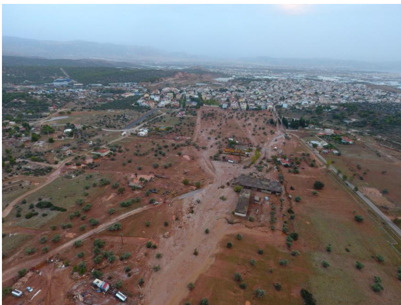
Εικόνα 10. Φωτογραφία της περιοχής της Μάνδρας με drone μετά την πλημμύρα.
