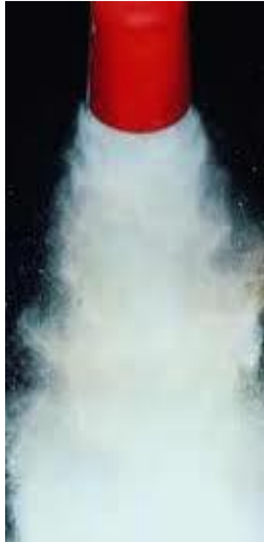
Εικόνα 2.18. Αυτόματο σύστημα πυρόσβεσης με κατασβεστικό υλικό καθαρού μέσου (χοάνη απελευθέρωσης του υλικού)
