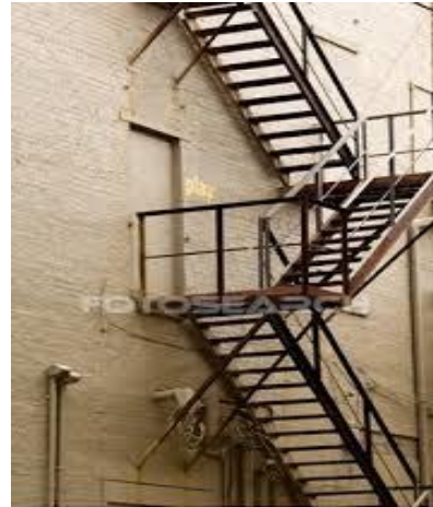
Εικόνα 2.2 Μεταλλικό εξωτερικό κλιμακοστάσιο
