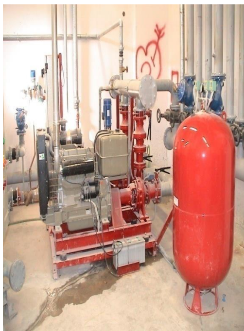
Εικόνα 2.19. Μόνιμο Πυροσβεστικό Υδροδοτικό Δίκτυο (πυροσβεστικές αντλίες)
