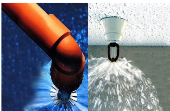
Εικόνα 2.11.Συστήματα ενεργητικής πυροπροστασίας, (σύστημα καταιονισμού ύδατος)
