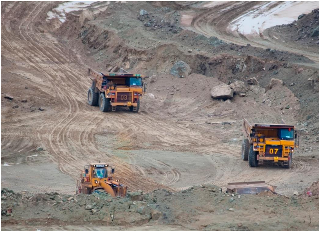
Εικόνα 53: Εργασίες σε ορυχείο θερμοκουλίτη (από www.palabora.us )
