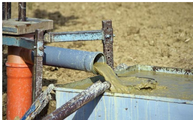
-Εικόνα 5.21: Απεικόνιση της διαδικασίας ανάκτησης του γεωτρητικού πολτού (αριστερά) και η εμφάνισή του στην επιφάνεια (δεξιά). Πηγή: E8210: «ΕΡΕΥΝΑ ΠΕΤΡΕΛΑΙΩΝ eclass.uoa.gr/courses/GEOL250/»
