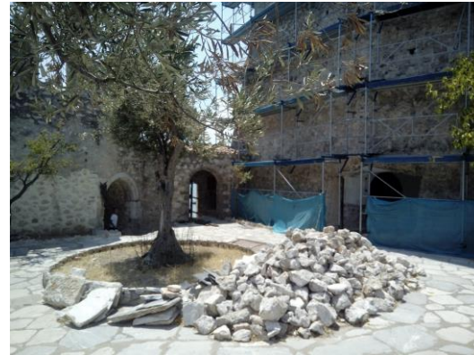
Εικόνα πλήρους εγκατάλειψης στο εσωτερικό του φρουρίου
