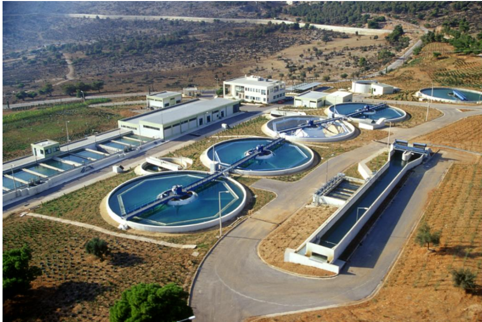
Εικόνα 3: Μονάδα επεξεργασίας νερού Ασπροπύργου [16]
