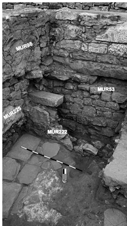
FIG. 7. – Angle sud-est de la pièce PCE64 de DOM5 : vestiges de BAT25 (dallage, murs MUR225, MUR222) ; vestiges de BAT24 (MUR98 lié au mortier, MUR53) ; vestiges de DOM5 (MUR98, MUR53) (photo EFA).
