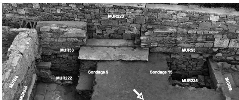
FIG. 6. – Sondages dans les angles sud-est et sud-ouest de la pièce PCE64 de DOM5 : vestiges de BAT25 (dallage, murs MUR225, MUR222, MUR235, MUR99) ; vestiges de BAT24 (MUR225, MUR53 fondation, MUR 99) ; vestiges de DOM5 (MUR98, MUR53 élévation) (photo EFA).
