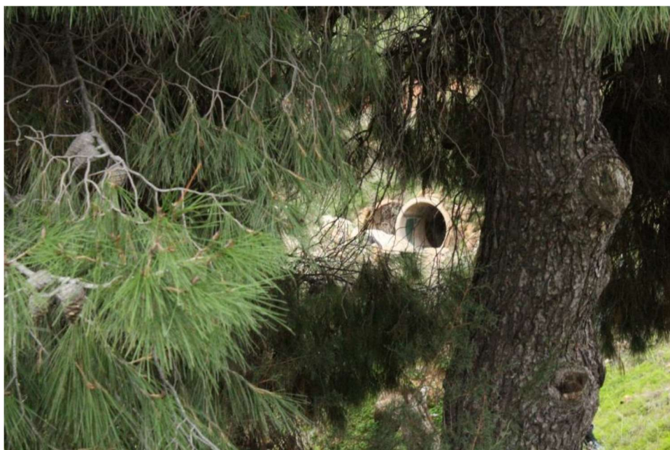
Σχήμα 4.6: Άποψη αγωγού αποστράγγισης προς τα ανάντη
