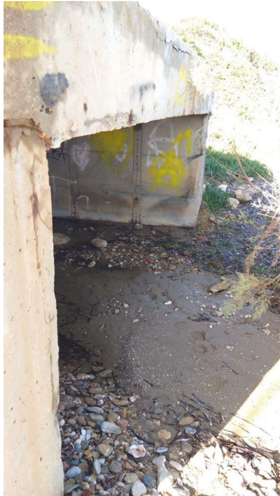
Σχήμα 4.3: Πλαινή άποψη του αγωγού αποστράγγισης στο σημείο παρατήρησης 1
