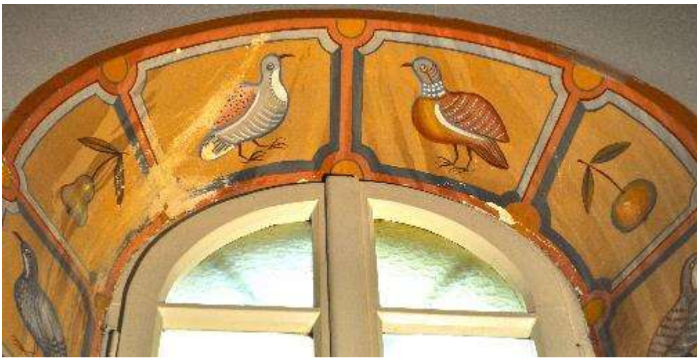
Εικ. 109. Αθήνα. Παρεκκλήσιο Αγίας Αικατερίνης του Κέντρου Βρεφών Μητέρα. Διακοσμητικά μοτίβα, (Προσωπικό αρχείο).
