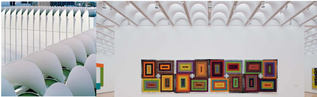
Εικόνα 12 α,β High Museum of art, Atlanta. Το σύστημα φεγγιτών στην οροφή και η απόδοση στο εσωτερικό εσωτερικό.
