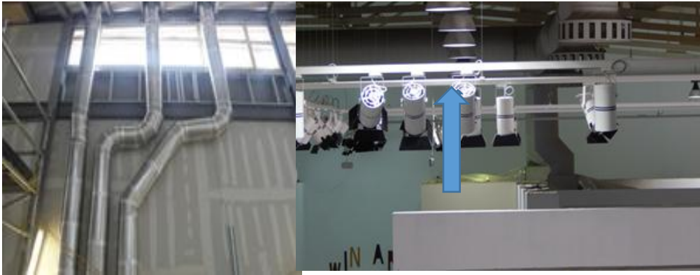
Εικόνα 13α,β Αγωγοί φωτός, μεταφορά φυσικού φωτός σε εσωτερικούς χώρους και εν λειτουργία σε εκθεσιακό χώρο.
