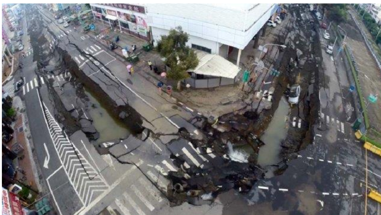
Εικόνα 10 Εικόνα της καταστροφής από την έκρηξη στο Καοσιουνγκ της Ταιβάν το 2014. Διακρίνονται το κατεστραμμένο οδικό δίκτυο και κατεστραμμένα αυτοκίνητα. Πηγή: (Liaw, 2016).
