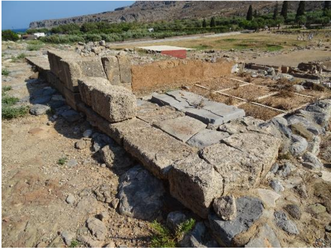
Εικόνα 5.26: Κτήριο D-E ή «Λοξό Κτήριο».
