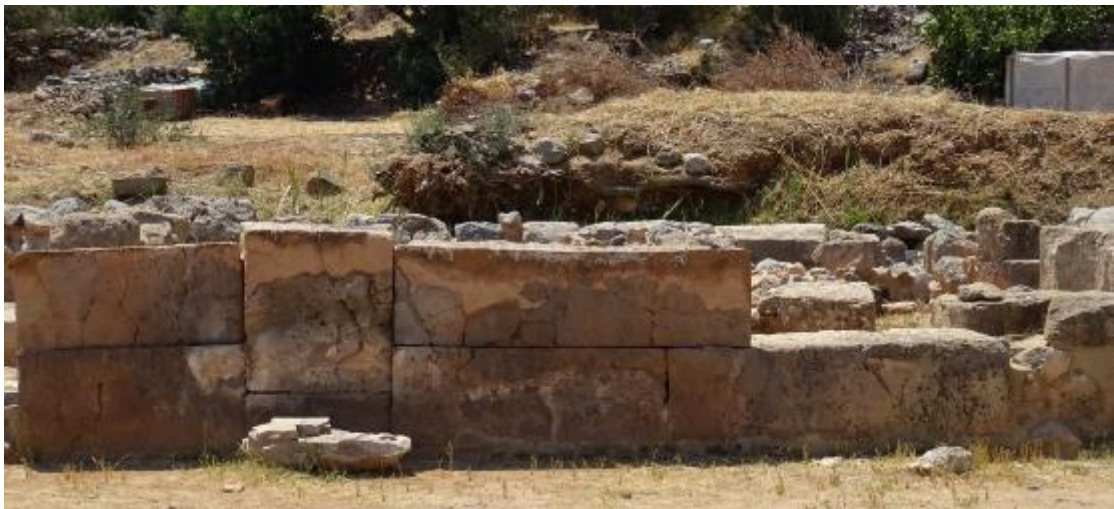
Εικόνα 8.18: Θραύσεις και ρηγματώσεις παλαιών κονιαμάτων.
