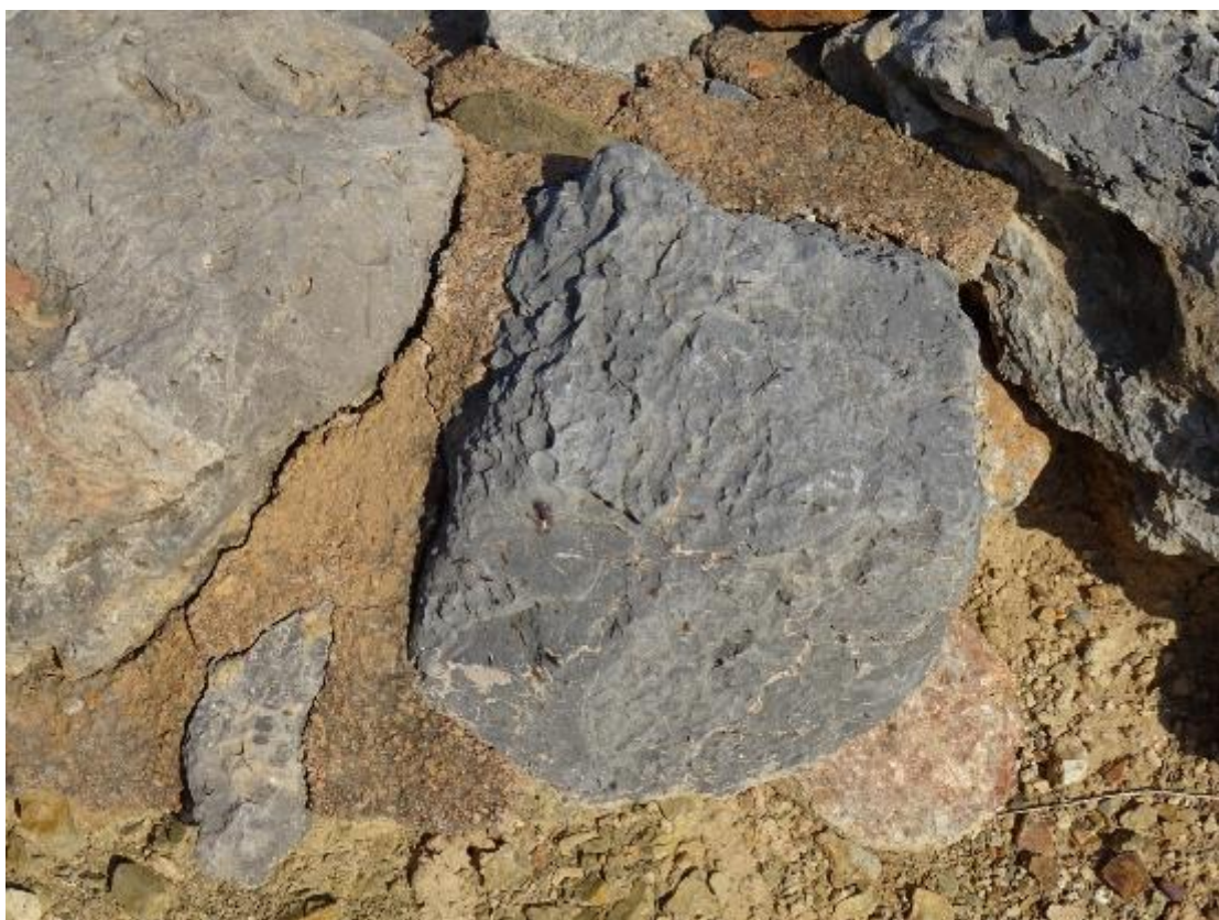
Εικόνα 8.19: Θραύσεις και ρηγματώσεις παλαιών κονιαμάτων.
