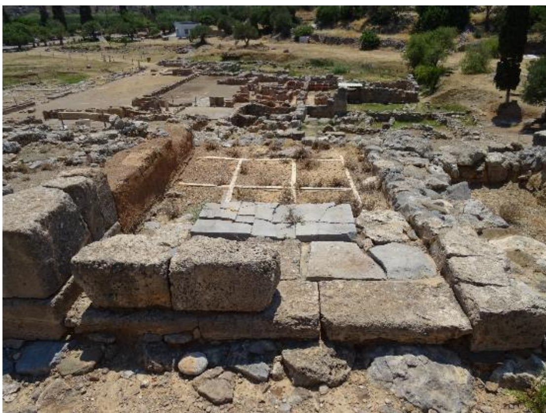
Εικόνα 8.11: Παρασιτική βλάστηση στην κεντρική είσοδο του Κτηρίου D-E.
