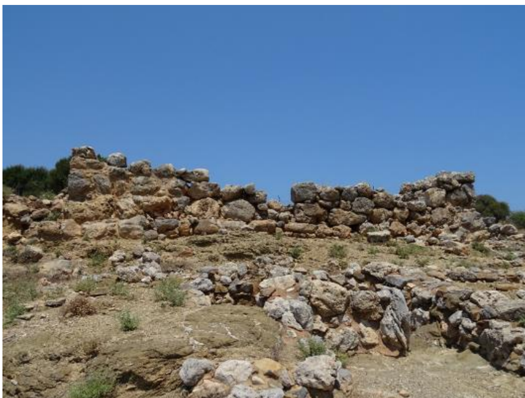
Εικόνα 2.7: Πρόσοψη Κτηρίου G.
