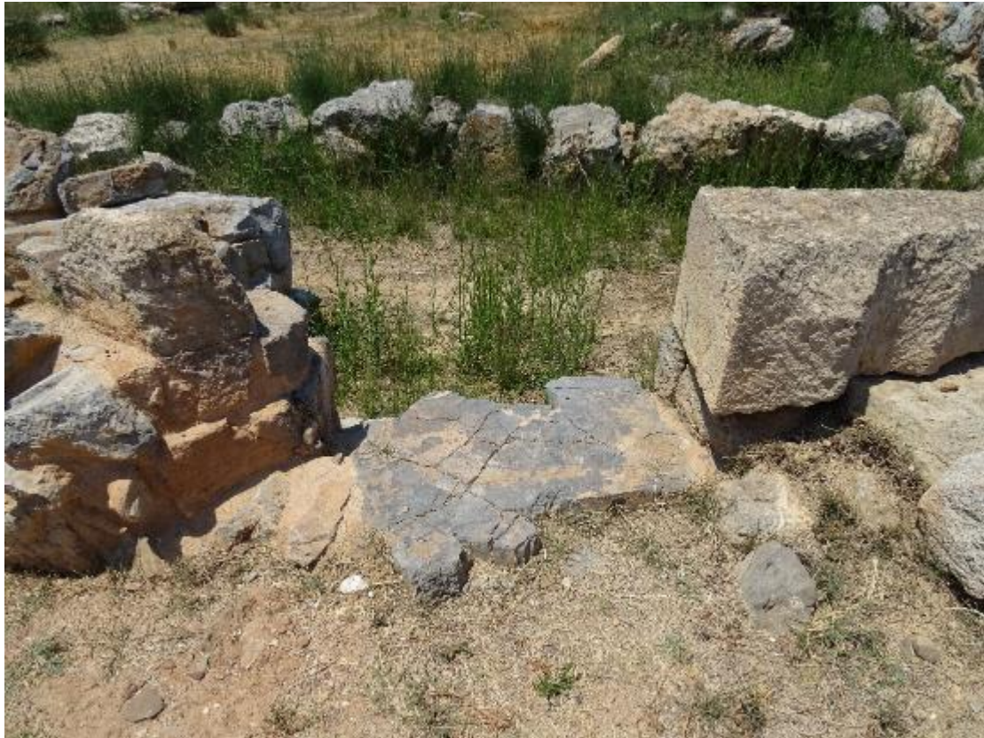
Εικόνα 8.2: Κατώφλι στη νότια πλευρά του ανακτορικού συγκροτήματος, με φαινόμενο κατακερματισμού.
