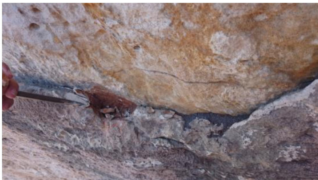
Εικόνα 7.55: Απόσπαση Ψαμμίτη - Πελεκητά.
