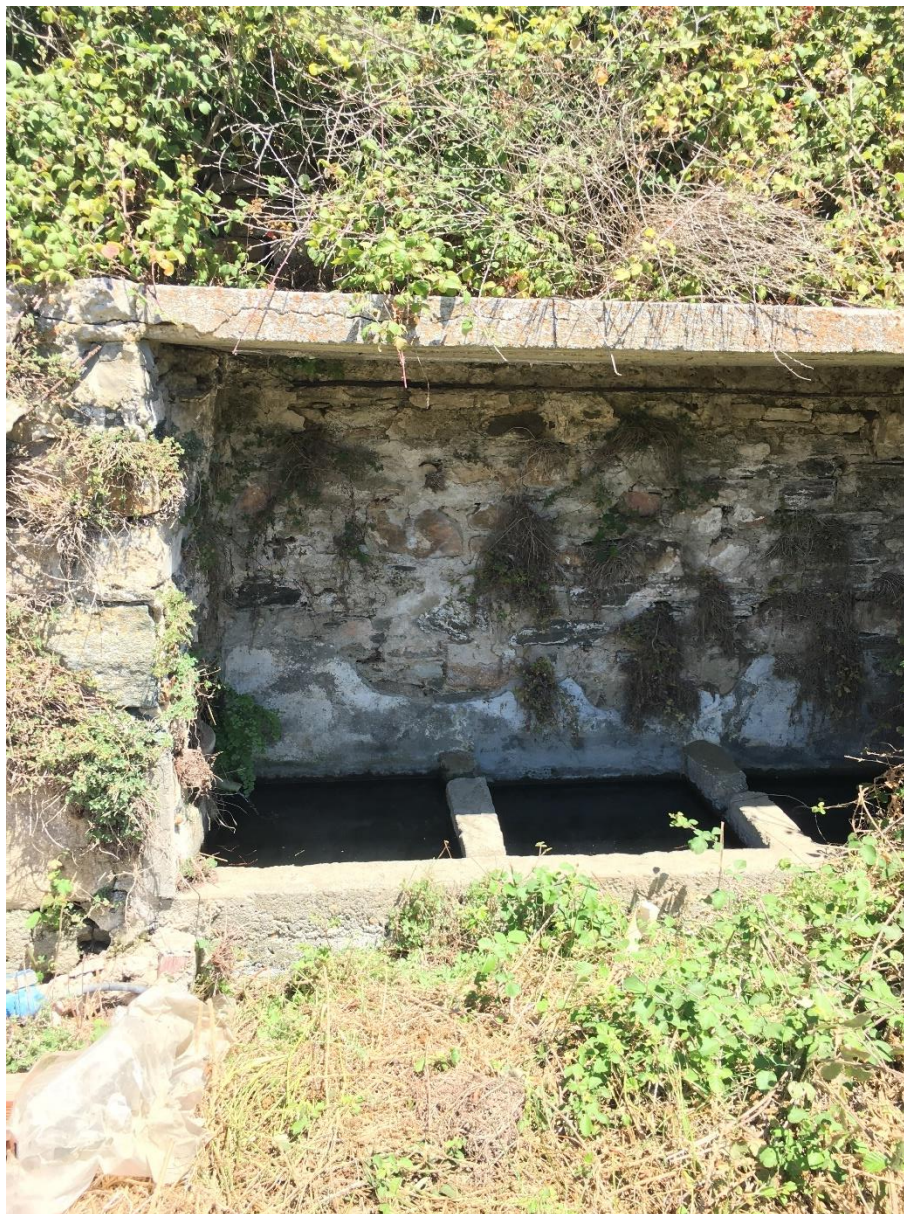
Φωτογραφία 15. Πηγή 9: Ενετικό Υδραγωγείο.
