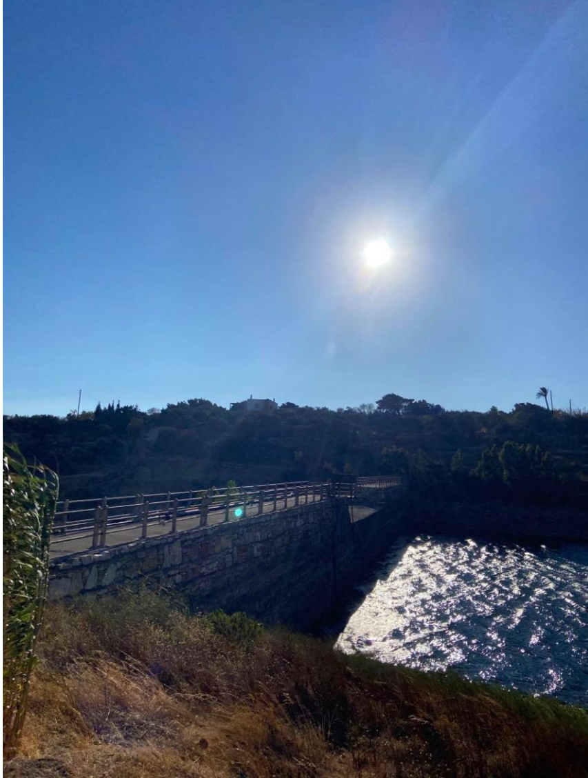
Φωτογραφία 3 α -β. Φράγμα Βακέτας.
