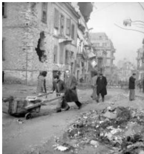
106. Κατεστραμμένο κτήριο από την «μάχη της Αθήνας», Δεκέμβριος 1944. Φωτογραφικό αρχείο Μουσείου Μπενάκη.
