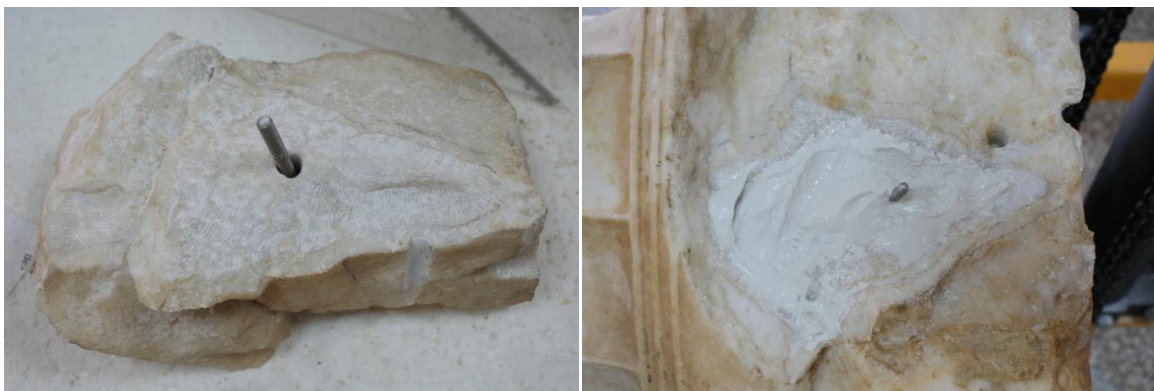
Figure 4 Προετοιμασία επιφανειών προς συγκόλληση. Αριστερά θραύσμα κιονόκρανου 115
