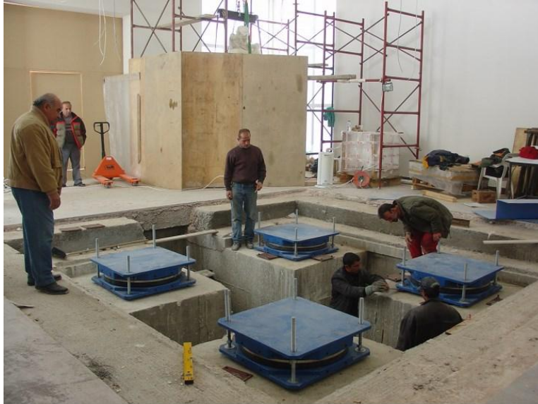
Figure 13 Σύστημα αντισεισμικής θωράκισης για τον Ερμή του Πραξιτέλη στο Μουσείο της Αρχαίας Ολυμπίας, με τοποθέτηση προκατασκευασμένης βάσης και τεσσάρων εφεδράνων ολίσθησης 136
