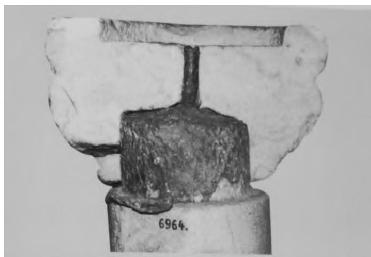
Εικ. 114. Ακρόπολη Αθηνών. Τεχνική συναρμογής κιονοκράνου με κίονα– K15 .
