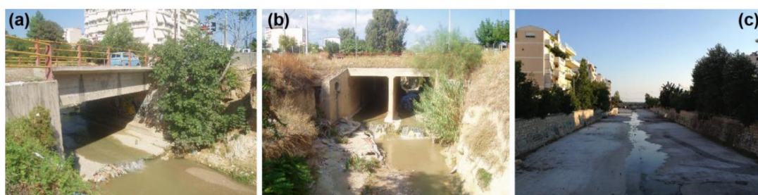
Εικόνα 4. Τυπικά παραδείγματα της κατάστασης του υδρογραφικού δικτύου της Αθήνας, συμπεριλαμβανομένων (a) περιπτώσεων μείωσης της διατομής του ρεύματος λόγω κατασκευής γέφυρας, (b) ρευμάτων, τα οποία έχουν καλυφθεί ή μετατραπεί σε δρόμους και (c) κτηρίων που έχουν κατασκευαστεί ακριβώς δίπλα στην κοίτη του ρεύματος σε περιοχή ευεπηρεάστη στην δράση πλημμυρικών φαινομένων (Diakakis et al., 2014)
