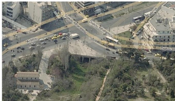
Εικόνα 3. Η γέφυρα της οδού Αναπαύσεως (στο κέντρο) και η εκκλησία της Αγίας Φωτεινής (στα αριστερά) (Lekakis, 2019)
