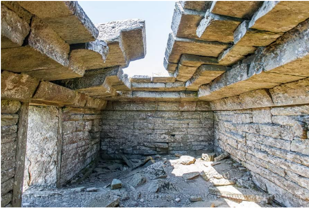
Εικόνα 414. Το εσωτερικό του «Δρακόσπιτου» στο όρος Όχη, με την εκφορική σκαφοειδή στέγαση ( www.google.gr/maps/place/Δρακόσπιτο (Dragon house) ), τελευταία σύνδεση 10/4/2020)
