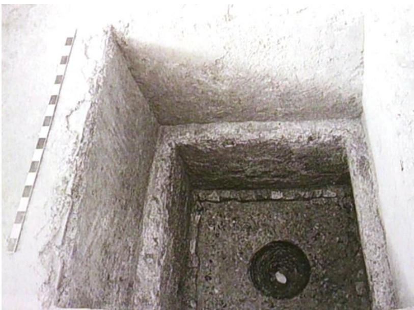
Εικόνα 274. Υπολάνιο της δεξαμενής Δ1, με προεξοχή και κοιλότητα καθαρισμού από το συγκρότημα ληνών στην Πάτρα, οδός Πηνειού 22 και Κλαδέου (Πετρόπουλος 2013, 169 εικ. 18).
