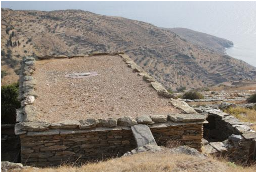
Εικόνα 408. Η πίσω όψη μητάτου στην ορεινή Νάξο. (Πρόγραμμα Ψηφιοποίησης-Αρχιτεκτονική ανάλυση παραδοσιακών κτηρίων και συνόλων, Σχολή Αρχιτεκτόνων-Μηχανικών, Εθνικό Μετσόβιο Πολυτεχνείο, http://5a.arch.ntua.gr/project , τελευταία σύνδεση 11/4/2020).
