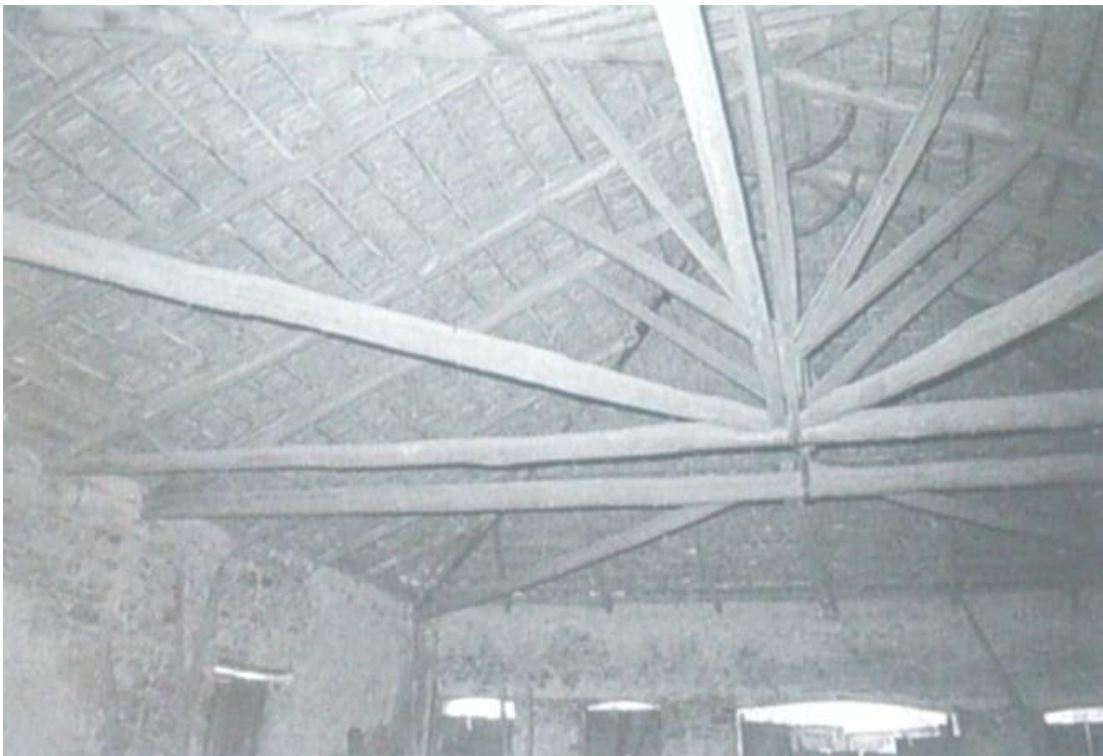
Εικόνα 536. Η ξύλινη στέγη του αγροτικού κτηρίου του 19 ου αιώνα στη Σάμο (Τουρνικιώτης 1992).
