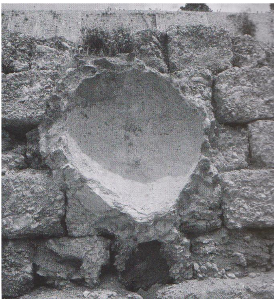
Εικόνα 567. Τμήμα κτιστού πίθου στο ανάλημμα της Στοάς του Ευμένους (Μπούρας 2017, 107 εικ. 65).
