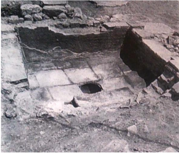
Εικόνα 297. Η δεξαμενή-υπολήνιο που διαθέτει δάπεδο στρωμένο με πλάκες και υδραυλικό κονίαμα στους αρμούς (Σαράντη 1997, πιν. 119 β).
