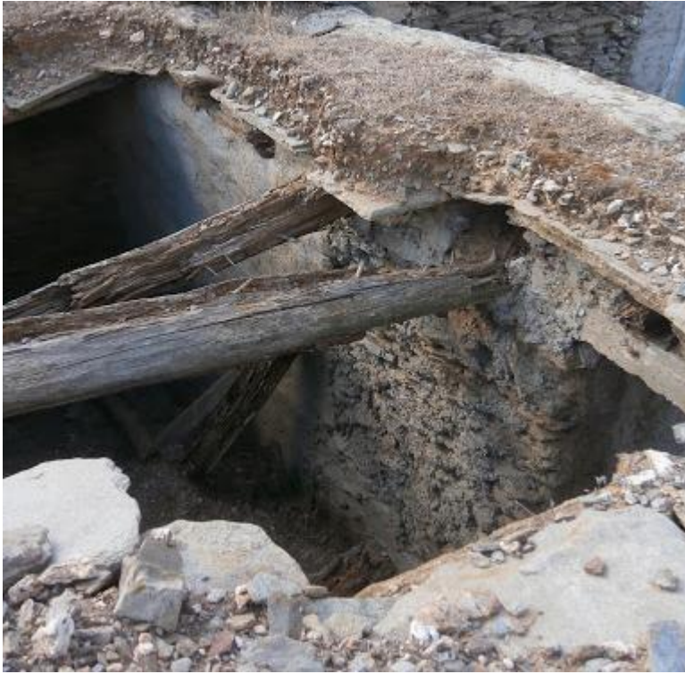
Εικόνα 409. Η κατασκευή της στέγης σε μητάτο στην ορεινή Νάξο (Πρόγραμμα Ψηφιοποίησης-Αρχιτεκτονική ανάλυση παραδοσιακών κτηρίων και συνόλων, Σχολή Αρχιτεκτόνων-Μηχανικών, Εθνικό Μετσόβιο Πολυτεχνείο, http://5a.arch.ntua.gr/project , τελευταία σύνδεση 11/4/2020).
