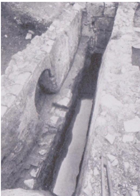
Εικόνα 373. Ο δυτικός τοίχος και το τοξωτό άνοιγμα της εγκατάστασης του υδρόμυλου στην Αθήνα (Parson 1936, 72 εικ. 2).
