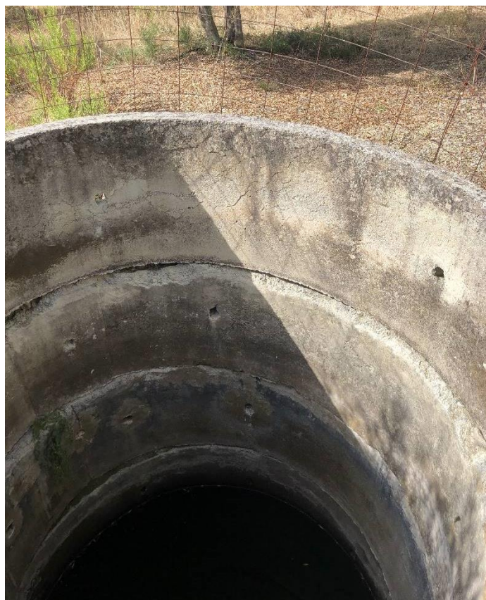
Εικόνα 5.8: Φρέατιος υδροφόρος ορίζοντας σε αδρομερή νεογενή σχηματισμό.
