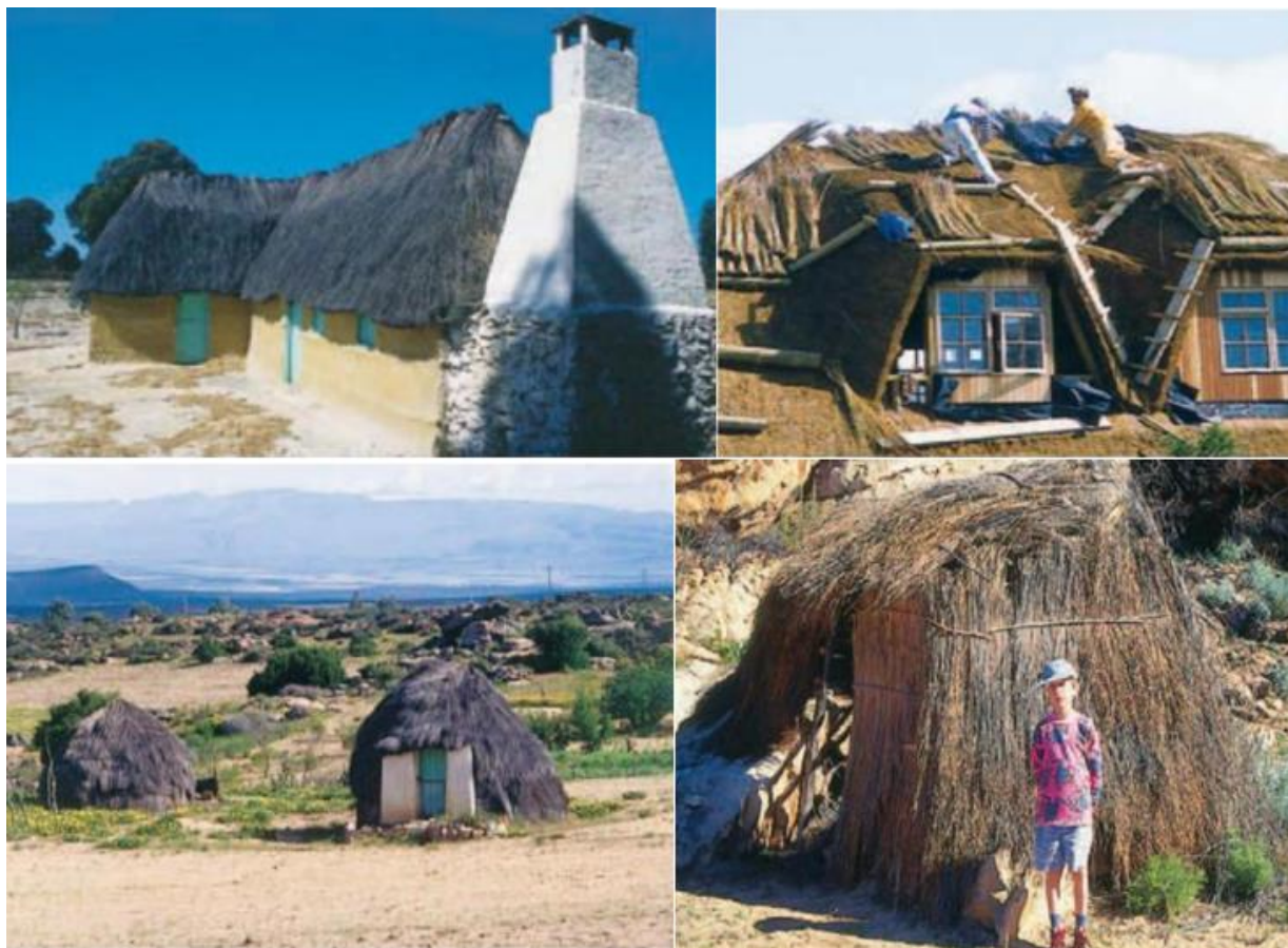
Εικόνα 11. Παραδείγματα σκεπών και ολόκληρων οικισμάτων κατασκευασμένα με την χρήση διαφόρων ειδών της οικογένειας Restionaceae (Dorrat-Haaksma and Linder, 2012).
