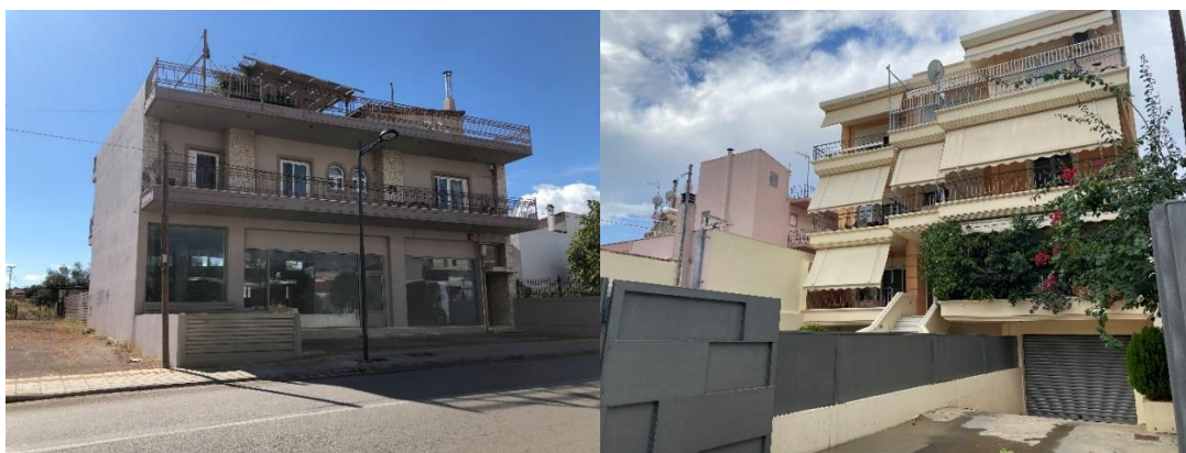
Εικόνα 14: Κτίριο 150 και κτίριο 770 με ράμπα υπογείου γκαράζ.
