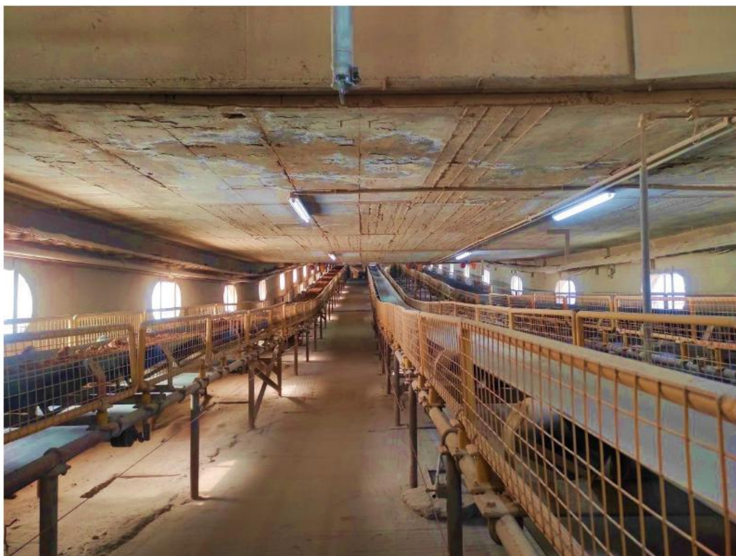
Εικόνα 7: Εργοστάσιο Καμαρίου - Μεταφορά θρυμματισμένων υλικών μέσω ταινίας. Στην εικόνα εντοπίζονται 3 ταινίες. Αριστερά γίνεται η μεταφορά του τόφφου, στο κέντρο γίνεται μεταφορά σιδηρούχου υλικού και στην δεξιά ταινία μεταφέρεται στους σωρούς, ο ασβεστόλιθος.
