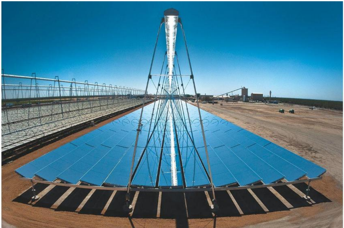
Εικόνα 126: Fresnel Reflectors - Concentrated Solar Power (ResearchGate).
