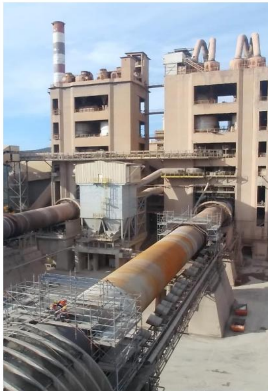
Εικόνα 16: Εγκαταστάσεις προθερμαντών 1 & 2, και περιστροφικοί κλίβανοι 1 & 2 (ΠΚ1, ΠΚ2) Εργοστάσιο Καμαρίου )
