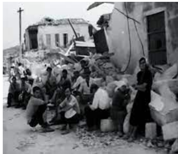
2. Σεισμός Αργοστολίου 12.08.1953 ( mixanitouxronou.gr )
