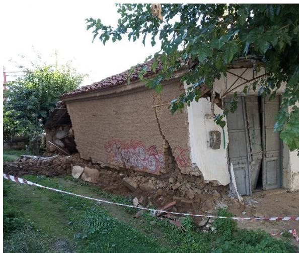
33. Πλίθινο υπό κατάρρευση κτήριο στην Καρδίτσα χτυπημένο από την πλημμύρα «Ιανός» 18-19.09.2020 (Προσωπικό Αρχείο)
