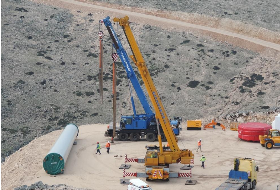
Εικόνα 3.1. Εργασίες εγκατάστασης αιολικού πάρκου σε αρχικό στάδιο
