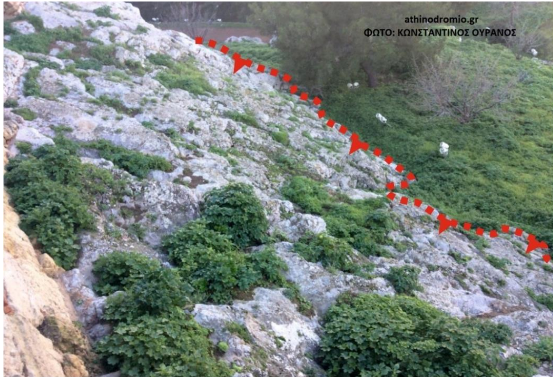
Εικόνα 2.13. Τεκτονική επαφή του ασβεστόλιθου πάνω στον αθηναϊκό σχίστη στη νότια κλιτύ του λόφου. Τα βελάκια δείχνουν το σώμα που υπέρκειται. (Αρχοντίκης, 2021).
