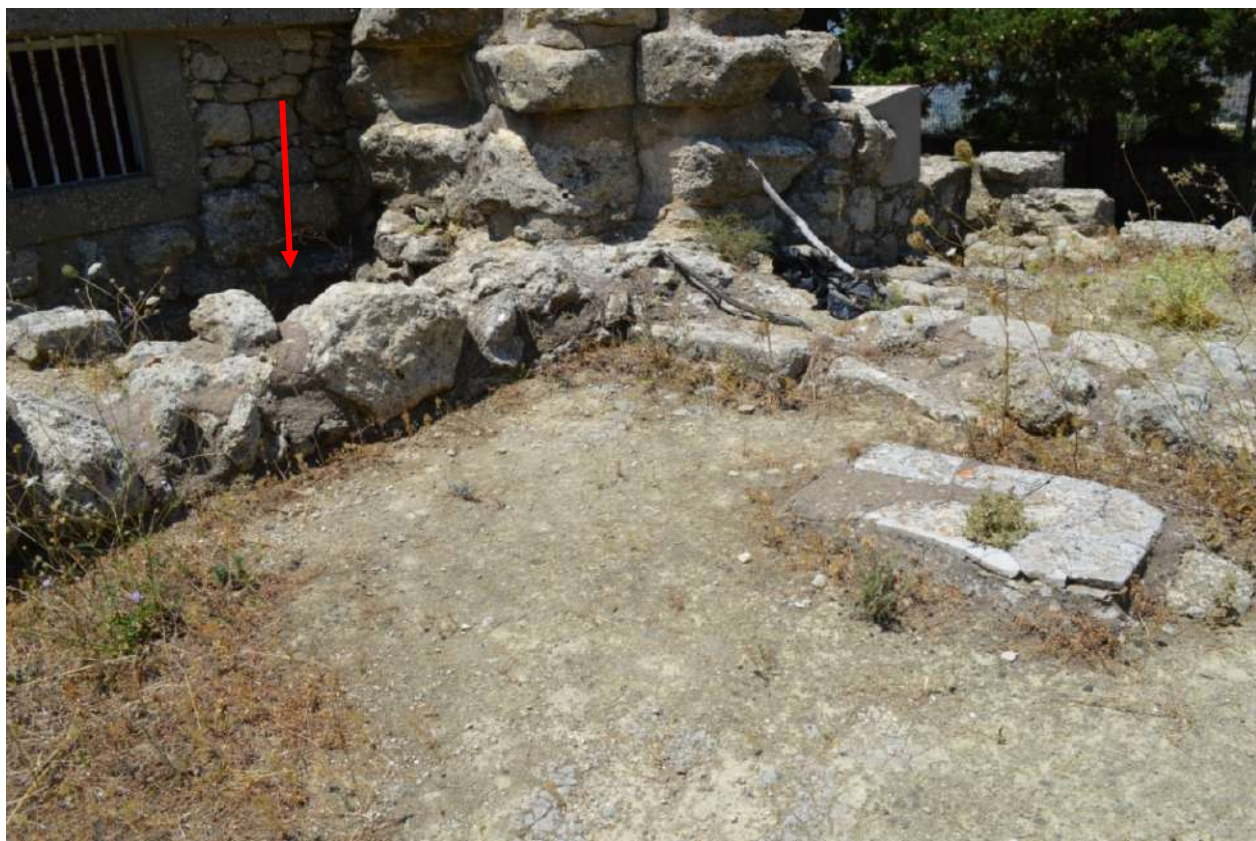
Εικ. 2: το νοτιοδυτικό τμήμα του Χώρου 18 με την ορθογώνια πλάκα - βωμό (στα δεξιά) και το σημερινό χωμάτινο δάπεδο· υποδεικνύεται νοτιότερα (στα αριστερά, με κόκκινο βέλος) η θέση του Χώρου 13, το δάπεδο του οποίου βρίσκεται σε χαμηλότερο επίπεδο (κατά περίπου ένα μέτρο) σε σχέση με το σημερινό, χωμάτινο δάπεδο του Χώρου 18.
