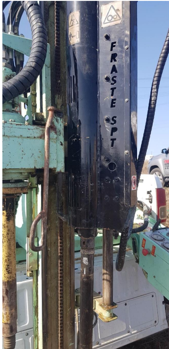
Εικόνα 5.2: Μηχάνημα που χρησιμοποιείται για την εκτέλεση της πρότυπης δοκιμής διείδυσης (SPT) [ΓΕΩΣΥΜΒΟΥΛΟΙ ΕΠΕ – ΚΑΤΑΣΚΕΥΗ ΝΕΟΥ ΥΠΟΣΤΑΘΜΟΥ (GIS) ΣΤΗ ΣΑΝΤΟΡΙΝΗ, 2020]
