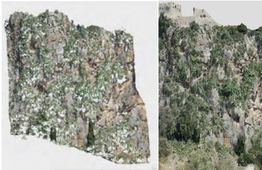
Εικόνα N11.1: Τμήμα πρανούς N11.
