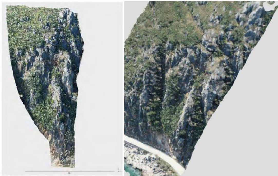
Εικόνα N6.1: Τμήμα πρανούς N6.
