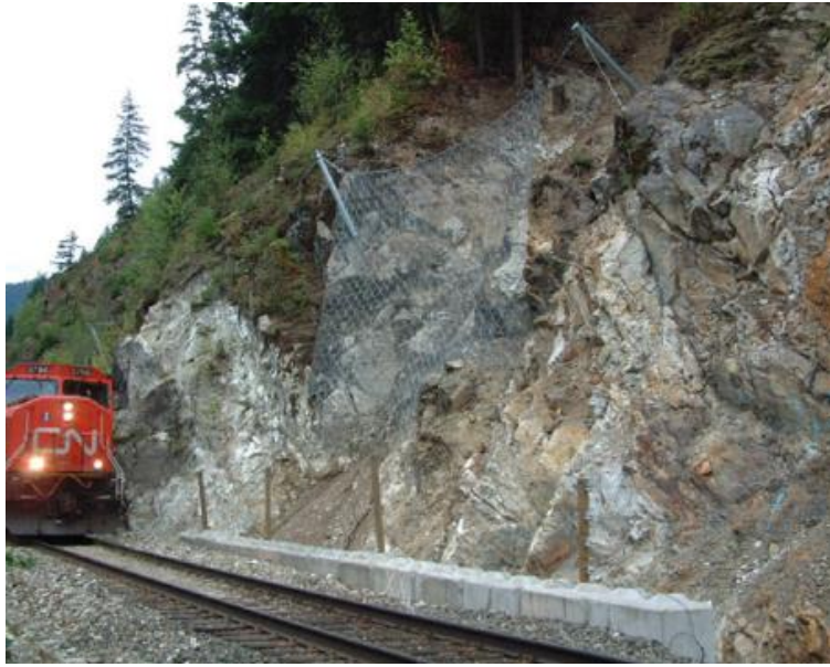
Εικόνα 8.2 Τυπικό σύστημα κουρτίνας και φράχτης προειδοποίησης κατά μήκος του πρηνούς δίπλα σε σιδηροδρομικές γραμμές (Bunce et al. 2006)
