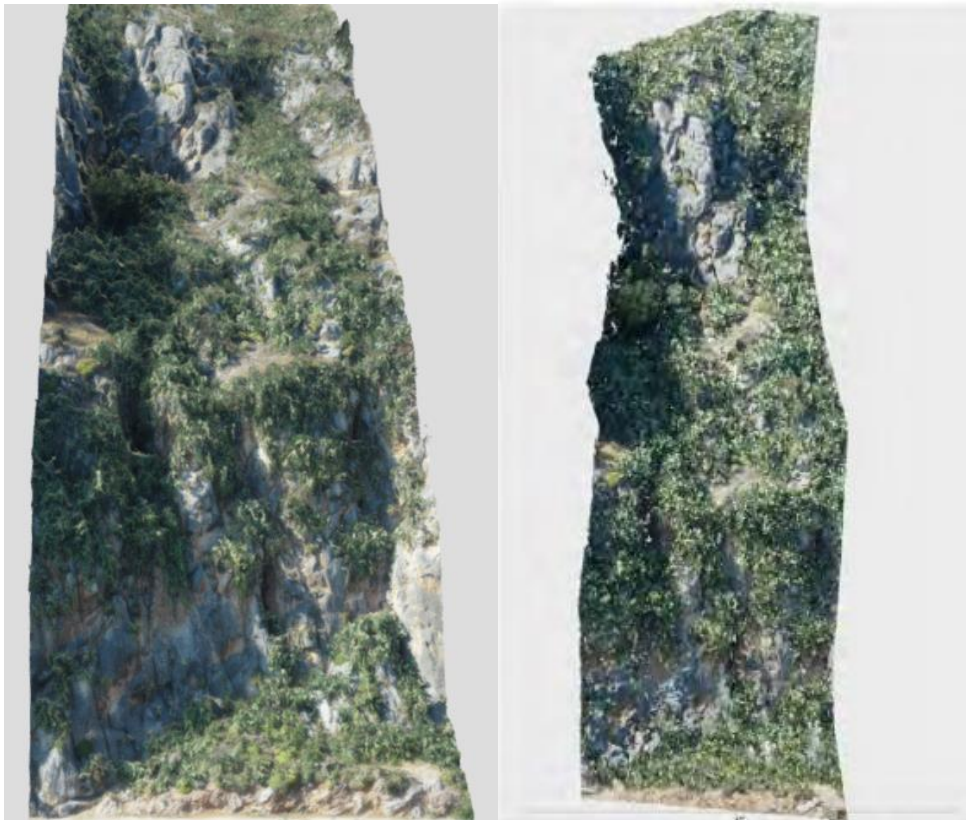
Εικόνα N7.1: Τμήμα πρανούς N7.
