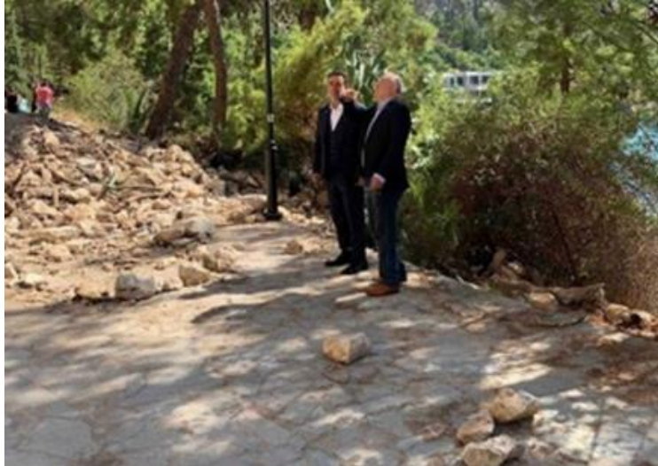
Εικόνα 1.2 Καταπτώσεις βραχωδών μαζών στο μονοπάτι της Αρβανιτιάς έπειτα από το γεγονός του Αυγούστου 2019 (Λέκκας κ.ά., 2022).
