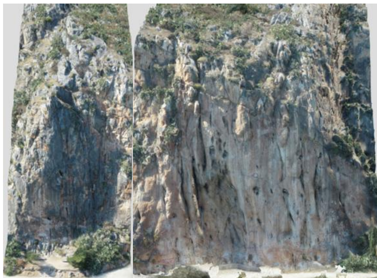
Εικόνα N8.1: Τμήμα πρανούς N8.
