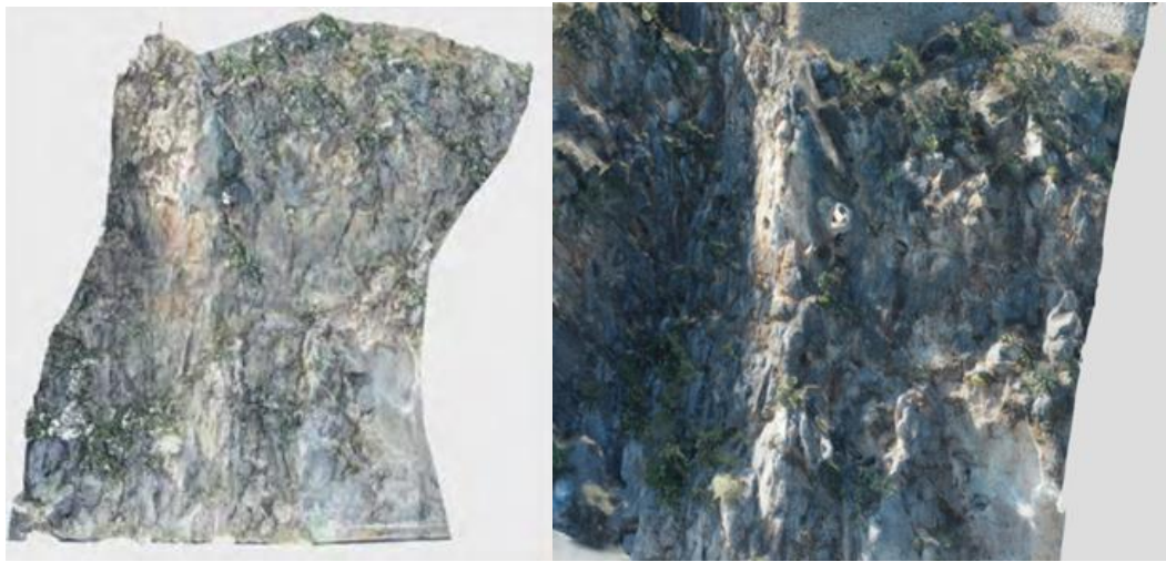
Εικόνα N2.1: Τμήμα πρανούς N2.
