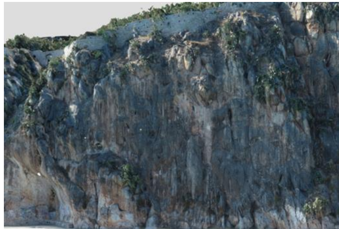
Εικόνα N4.1: Τμήμα πρανούς N4.
