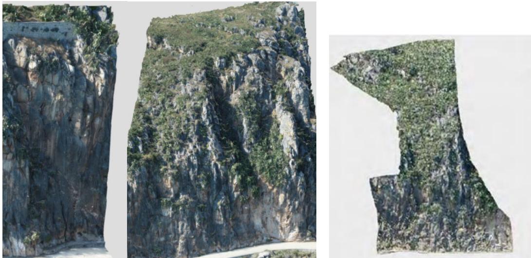
Εικόνα N5.1: Τμήμα πρανούς N5.
