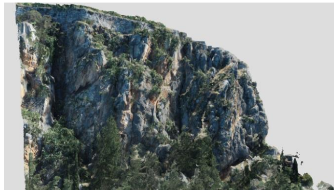
Εικόνα Β3.1: Τμήμα πρανούς Β3.
