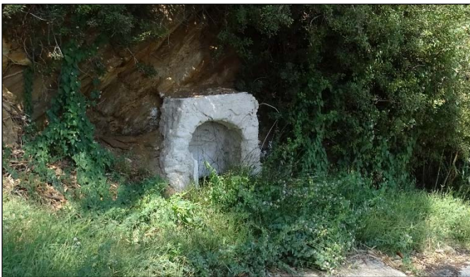
Εικόνα 8-8: Χαρακτηριστικός τρόπος υδρομάστευσης πηγής στον αποσαθρωμένο μανδύα των γρανατικών – μαρμαρυγιακών σχιστόλιθων (sch.ge) επί της οδού Χώρας – Μυλοπότα.
