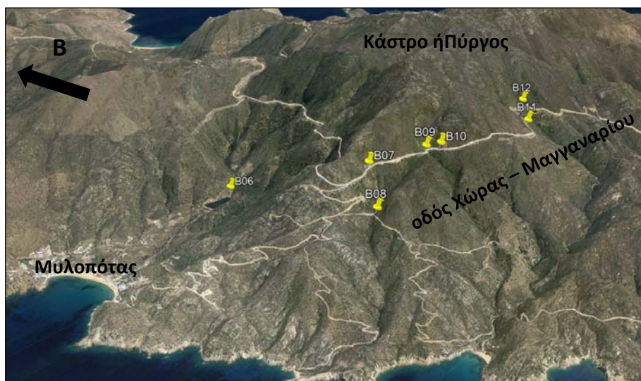
Εικόνα 8-10: Άποψη των θέσεων των δημοτικών υδρογεωτρήσεων B06, B07 (ανεργή), B08, B09, B10 (ανεργή), B11 (ανεργή) και B12 που εκμεταλλεύονται τη διερρηγμένη ζώνη των οφθαλμογενευσίων (gn) σε δορυφορική εικόνα Google Earth.
