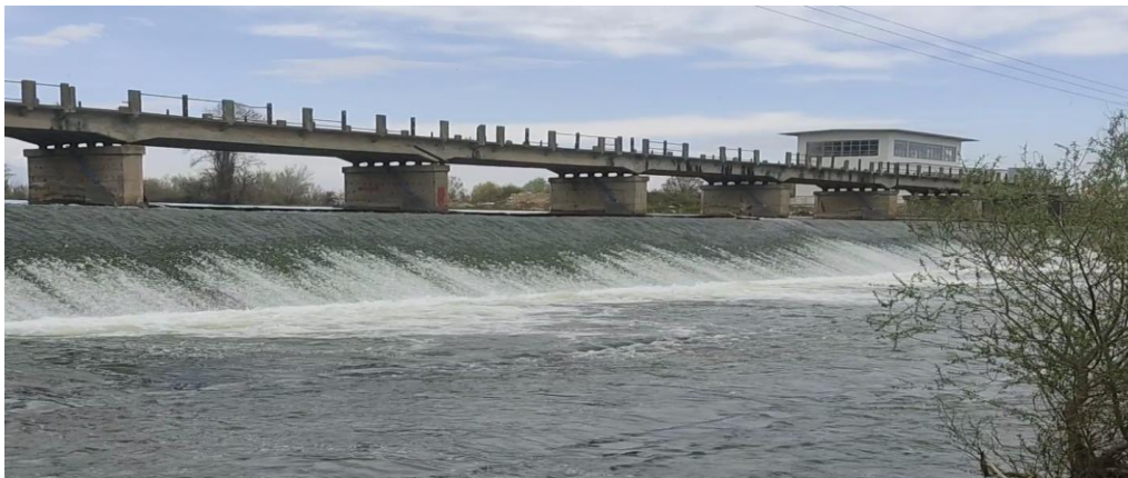
Εικόνα 44. Ο κατάντη πλευρά του αναβαθμού του Μ.Υ.Ε. της περιοχής μελέτης.
