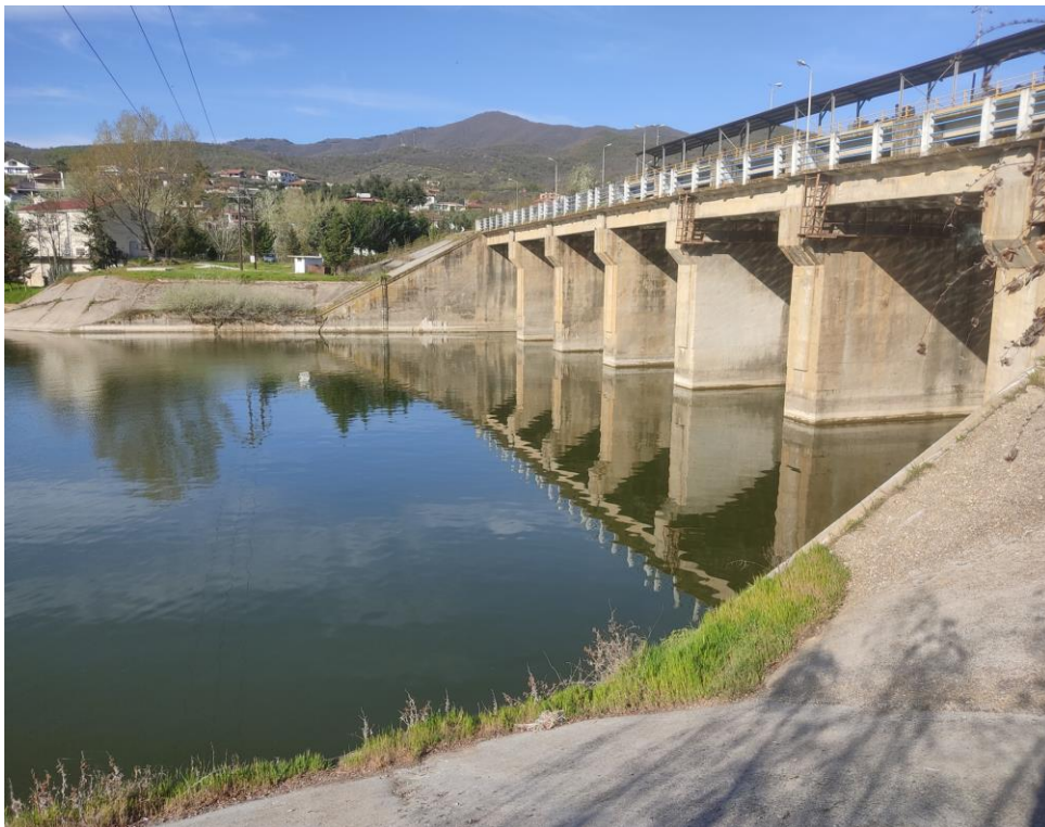
Εικόνα 64. Η κατάντη πλευρά του φράγματος της Λίμνης Κερκίνης
