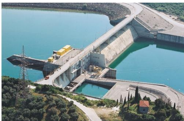
Εικόνα 49. Πουρνάρι I: Φράγμα υπερχειλιστή από σκυρόδεμα ύψους 41,6μ. Επί του ποταμού Αράχθου και σταθμός παραγωγής ενέργειας (4 μονάδων) (Πηγή www.terna.gr ) Terna SA - Ενεργειακά Έργα
