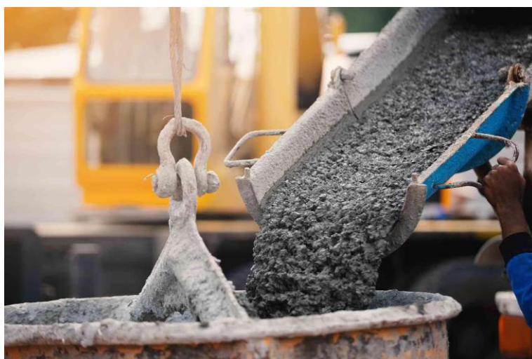
Εικόνα 6. Έκχυση σκυροδέματος (Πηγή: www.checkatrade.com )
