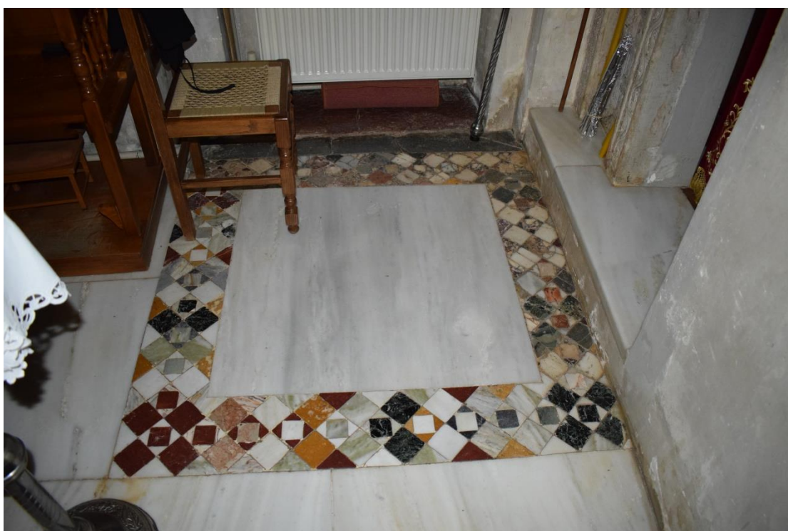
Εικ. 95: Μονή Οσίου Μελετίου, καθολικό, κυρίως ναός, βορειοανατολικό διαμέρισμα, τμήμα πλασίωσης διαχώρου του αρχικού δαπέδου (έμπροσθεν εισόδου της πρόθεσης).
