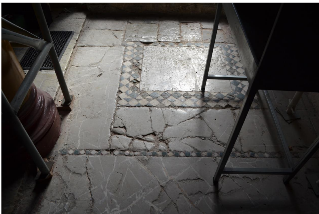
Εικ. 75: Μονή Βαρνάκοβας, καθολικό, κυρίως ναός, νότιο κλίτος, διάχωρο νοτιοδυτικής γωνίας.
