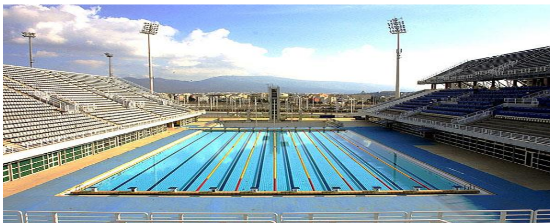
Εικόνα 6: Ανοιχτό Κολυμβητήριο ΟΑΚΑ
