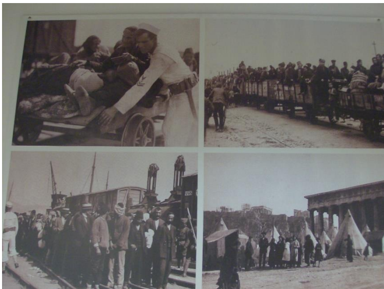
Εικ. 68 Φωτογραφίες από την Έξοδο και την εγκατάσταση
