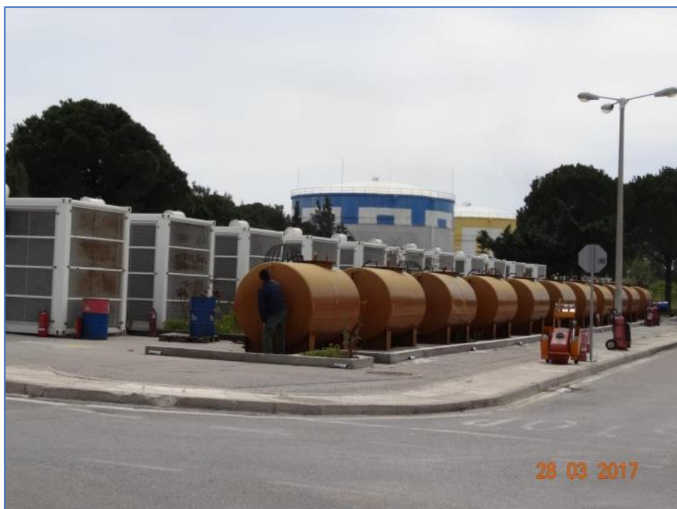
Εικόνα 32: Άποψη των Η/Ζ και των δεξαμενών καυσίμων τους.
