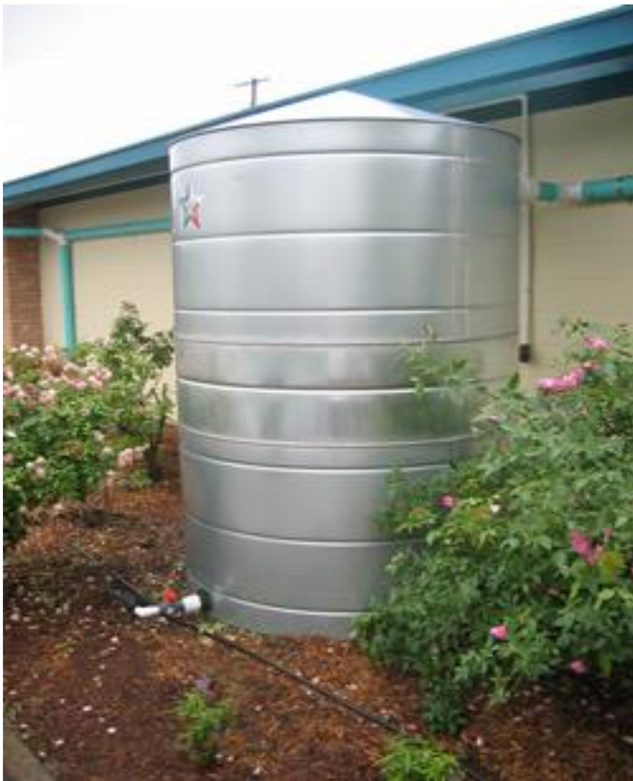
Εικόνα 12 Δεξαμενή συλλογής (Πηγή: https://enflow.gr/proionta/systimata-syllogis-apostraggisis-nerou/rainwater/ )
