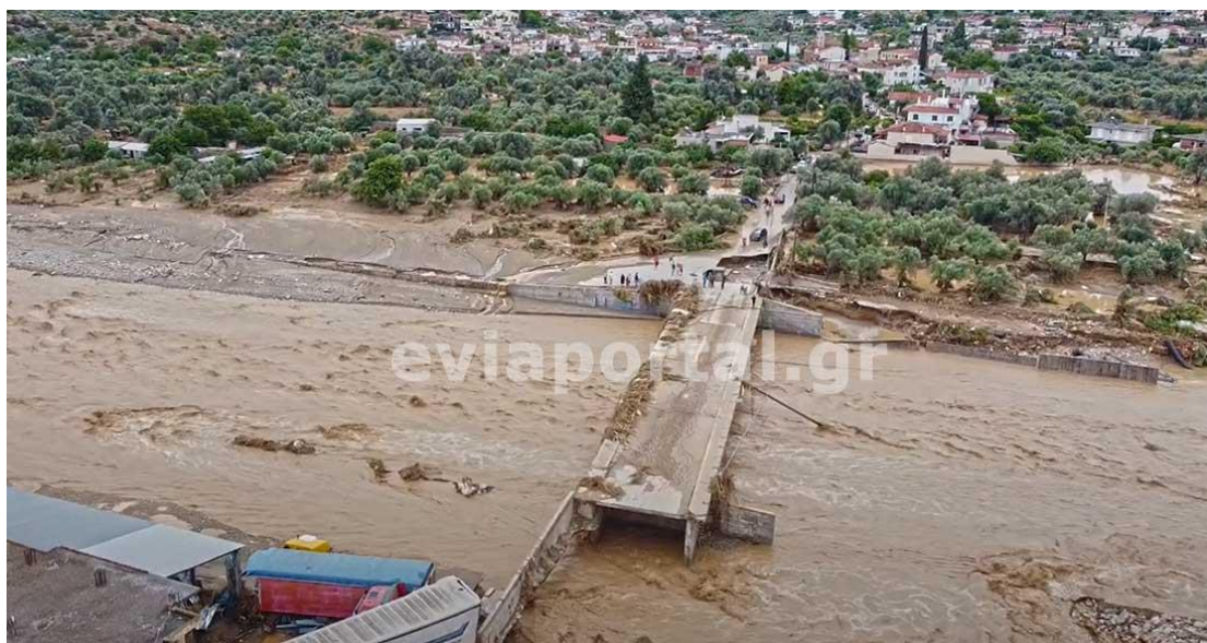
Εικόνα 31. Γέφυρα ποταμού Αφρατίου ( Πηγή: eviaportal.gr).
