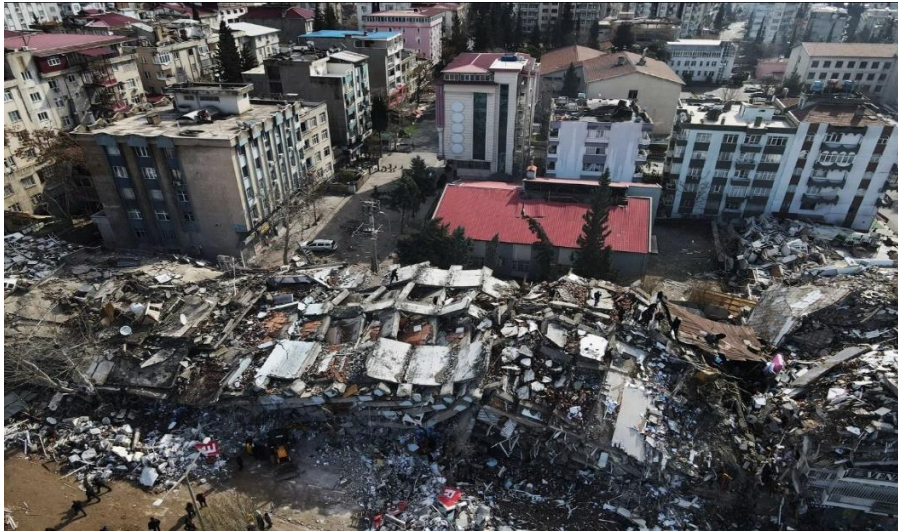
Εικόνα 7. Το κέντρο της Καχραμανμάρας στην Τουρκία, μετά από τον σεισμό που έπληξε τη νότια Τουρκία στις 6 Φεβρουαρίου 2023. Πολυώροφα κτήρια, συμπεριλαμβανομένων πολυκατοικιών και γραφείων, κατέρρευσαν.
