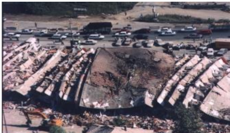
Εικόνα 5. Κατάρρευση κτιρίων εξαιτίας του σεισμού, στην επαρχία Κοτζάελι.
