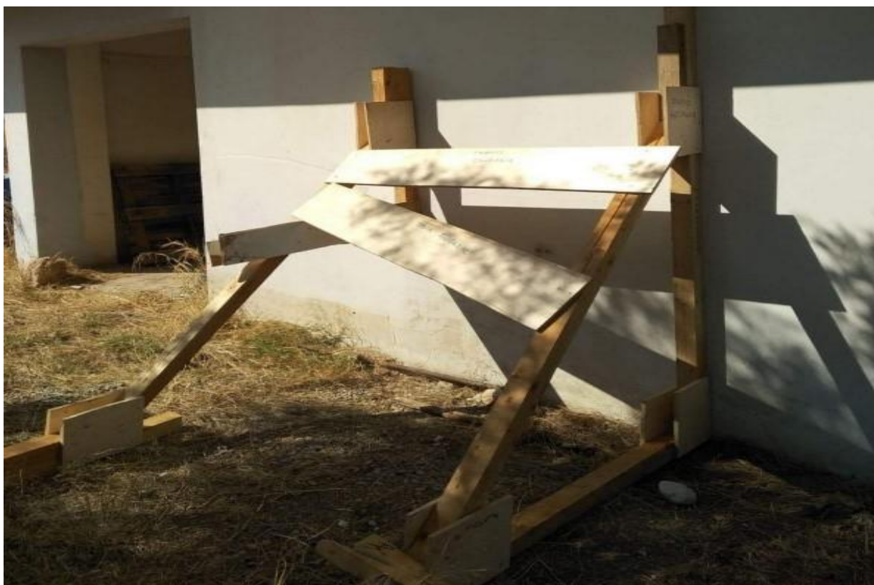
Εικόνα 3.2: Αντιστήριξη με αντηρίδες μικτής βάσης (Πηγή: Νίκας, 2020)
