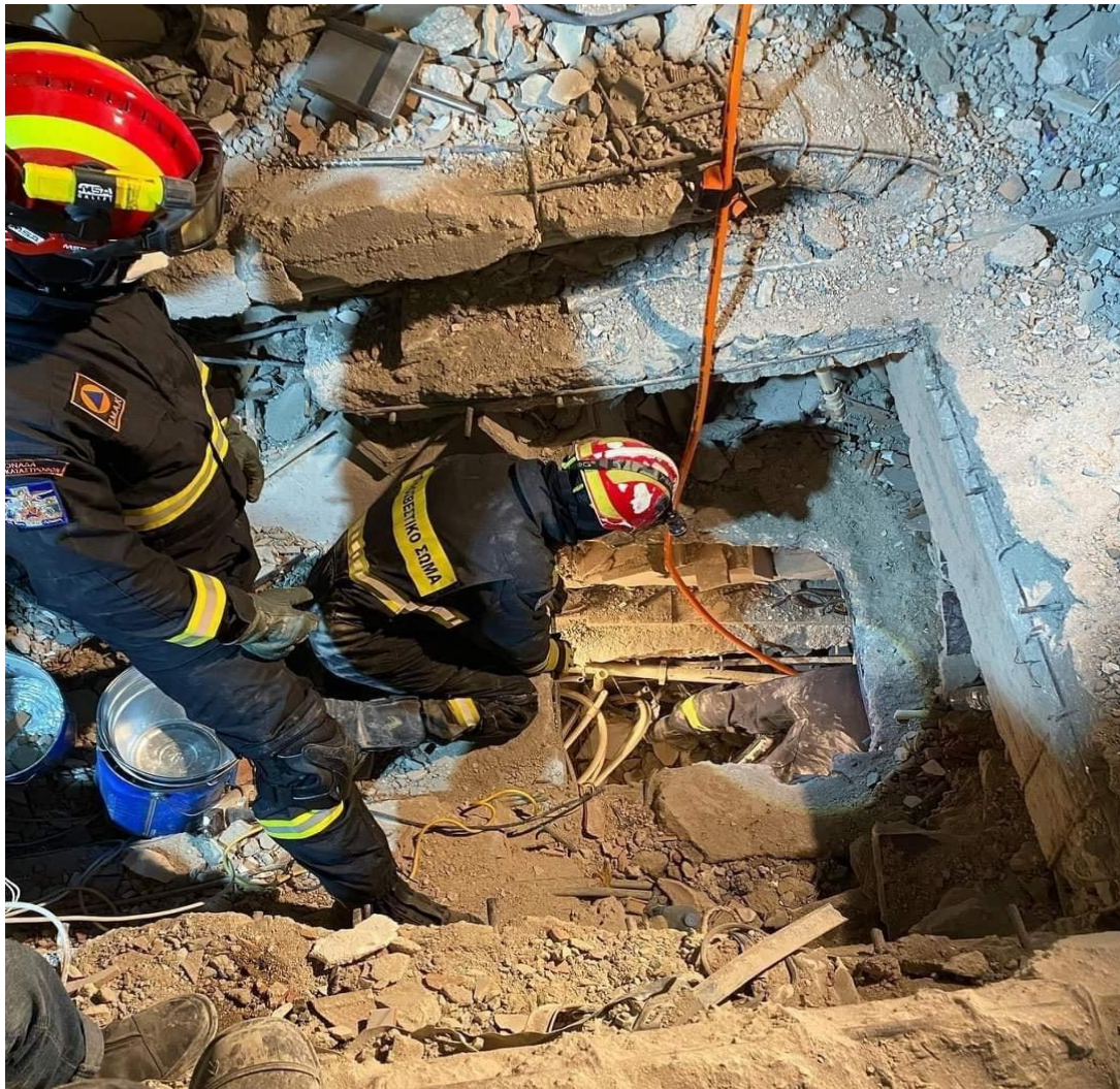
Εικόνα 4.11: Κατακόρυφη διείσδυση καθόδου για την διάσωση κοπέλας (Πήγη: Φωτογραφικό αρχείο Παπαδόπουλου Σταμάτιου)
