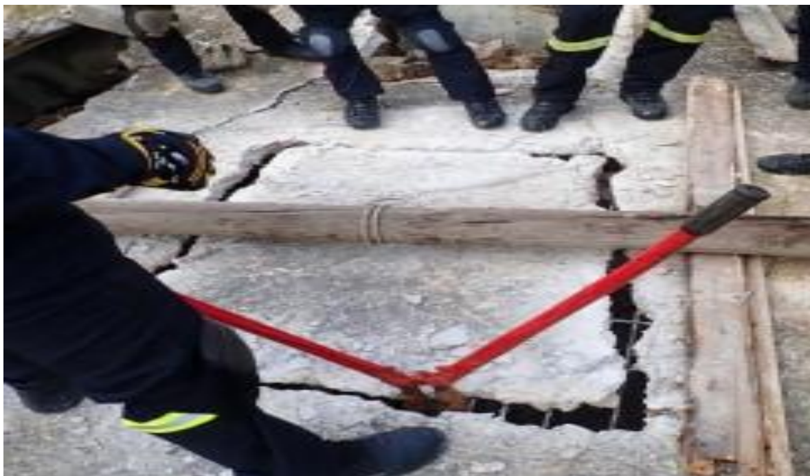
Εικόνα 3.10: Καθαρή κοπή με ξύλινο σύστημα συγκράτησης (Πηγή: Νίκας, 2019)
