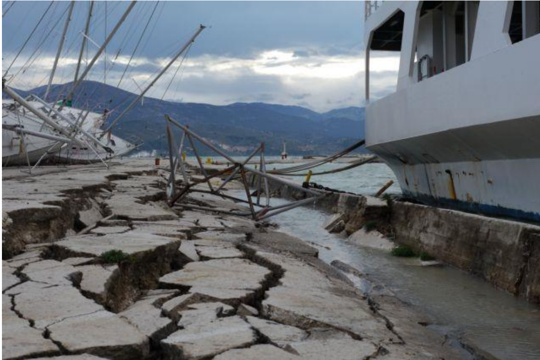
Εικόνα 1.13. Επιπτώσεις του σεισμού στην Κεφαλονιά (Newsroom, 2014)
