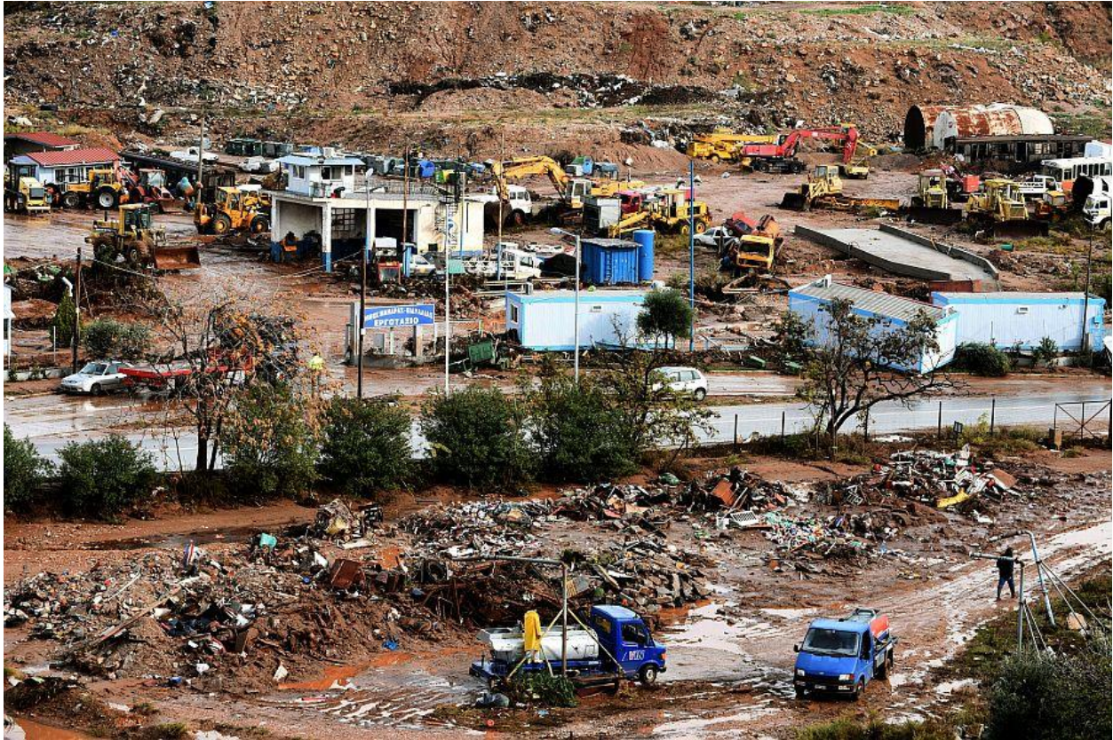
Εικόνα 3.6. Επιπτώσεις των πλημμυρών στο αυθαίρετο αμαξοστάσιο Μάνδρας (Newsbomb, 2019)
