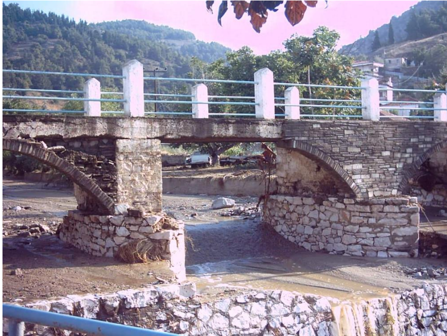
24 Figure: Η Γέφυρα στην Τσαριτσάνη (Μάνης, 2021)
