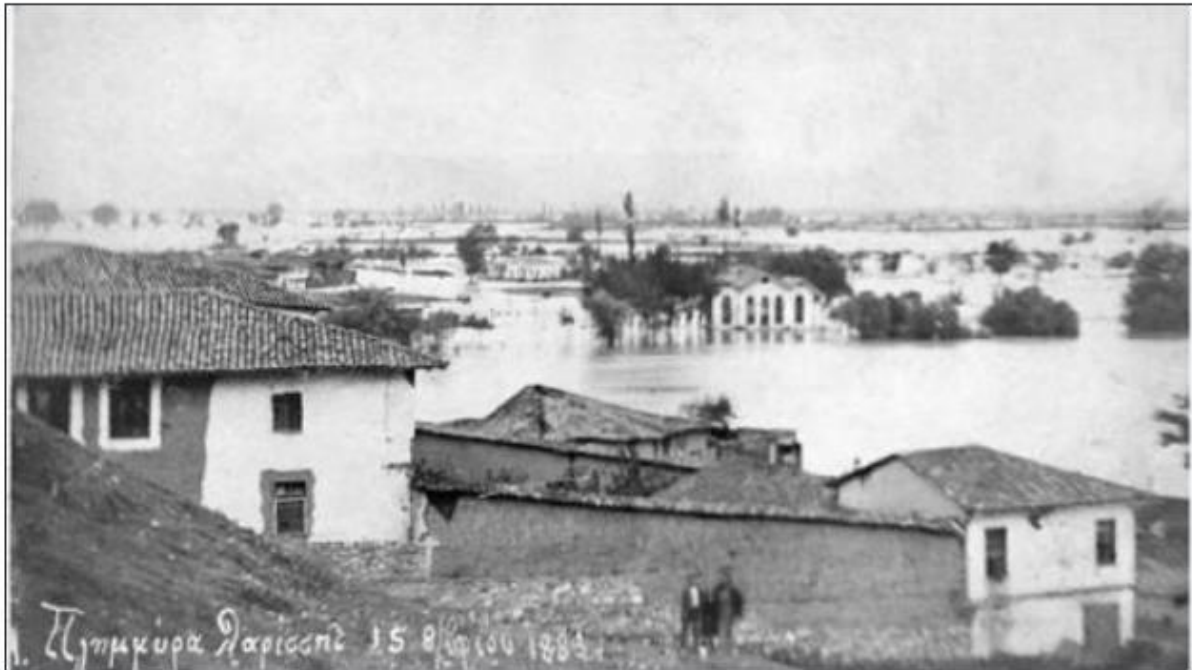
12 Figure: Εικόνα από την πλημμύρα της Λάρισας τον Οκτώβρη του 1883. Φωτογραφία του Λεονταρίδη Ιωάννη – Φωτογραφείο Μακεδονία (Κολυδάς, 2024)
