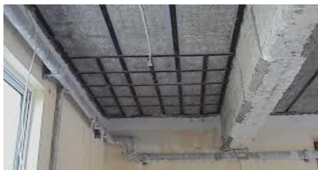
Εικόνα 29. Ενίσχυση και επισκευή πλάκας. (Πηγή: library.tee.gr)
