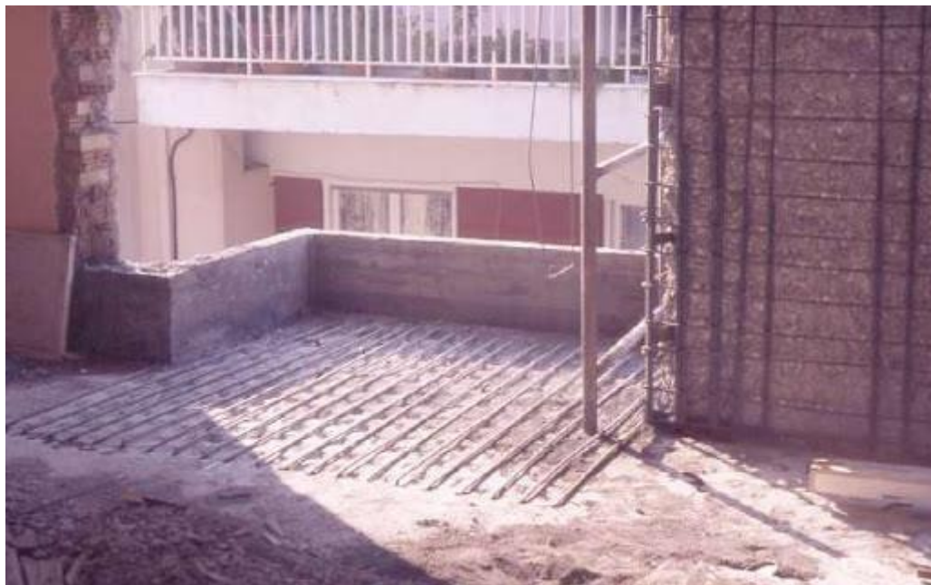
Εικόνα 30. Ενίσχυση και επισκευή προβόλου. (Πηγή: http://www.episkeves2.civil.upatras.gr/?page_id=22990 )
