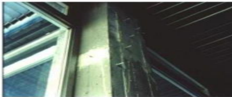
Εικόνα 14: επισκευή υποστυλώματος με ρητινενέσεις
