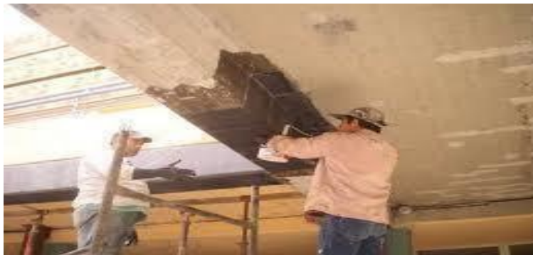
Εικόνα 23:Ενίσχυση και επισκευή δοκού(eclassteicrete.gr)
