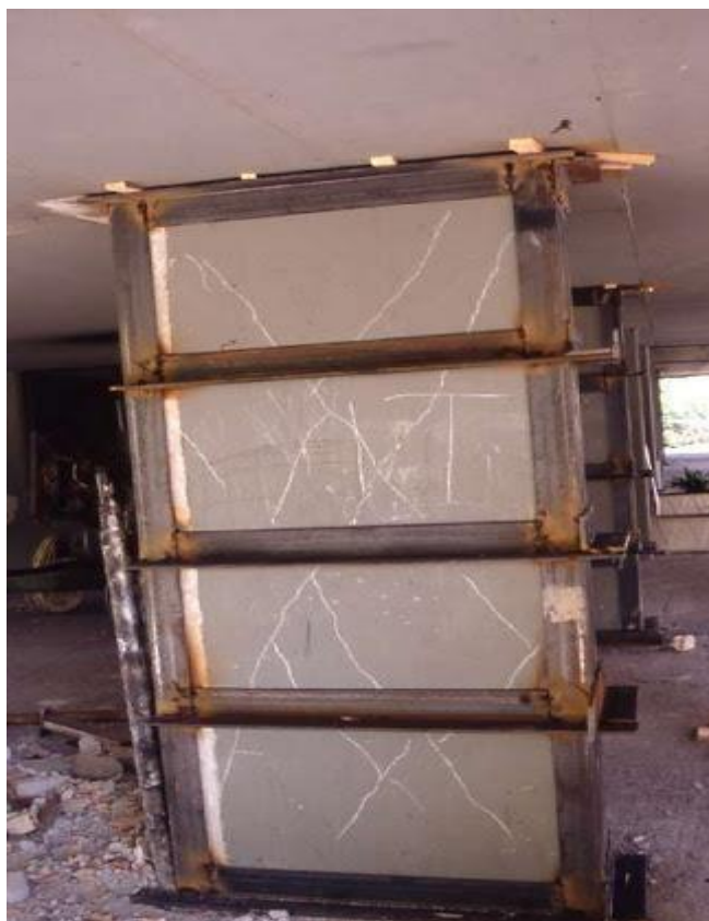
Εικόνα 25: Ενίσχυση και επισκευή τοιχώματος (Πηγή: http://www.episkeves2.civil.upatras.gr/?page_id=1026 )
