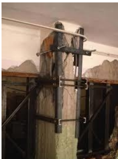
Εικόνα 19: Ενίσχυση και επισκευή υποστυλώματος (eclassteicrete.gr)
