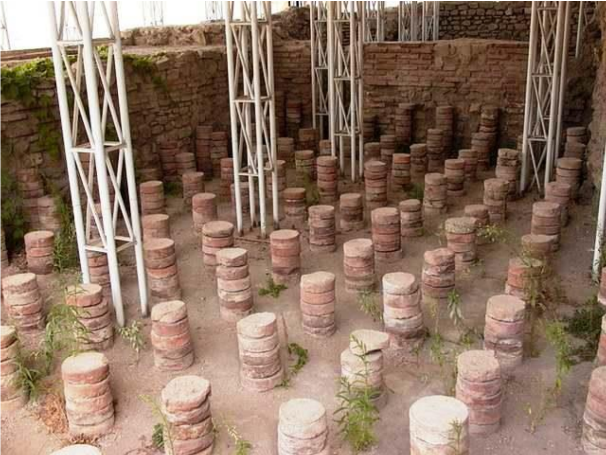
8.7 Ο χώρος των υπόκαυστων
