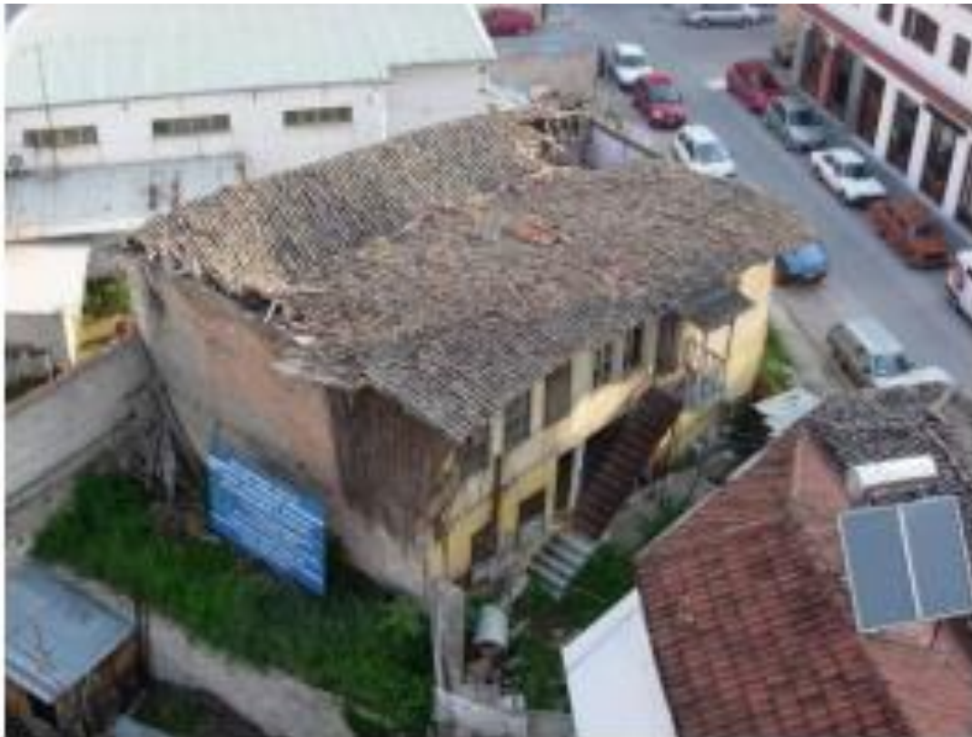
11.6 Κτίριο υπό κατάρρευση στην ανατολική γωνία του αρχαιολογικού χώρου.
