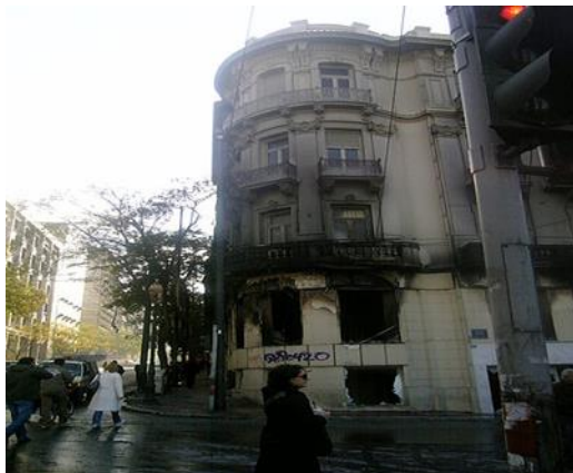
Φωτ. 6.: Το κτήριο επί των οδών Ακαδημίας 47 και Σίνα, μετά τη φωτιά που ξέσπασε το βράδυ της 8 ης -9 ης Δεκεμβρίου 2008. (Ταραχές του Δεκεμβρίου 2008 στην Ελλάδα)
