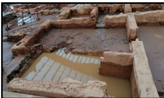
Εικόνα 10.60. Αποτύπωμα πλημμύρας στον εσωτερικό του χώρο, καθώς και στην ευρύτερη περιοχή των στεγάστρων προφύλαξης του Αρχαιολογικού Χώρου Μαλίων
