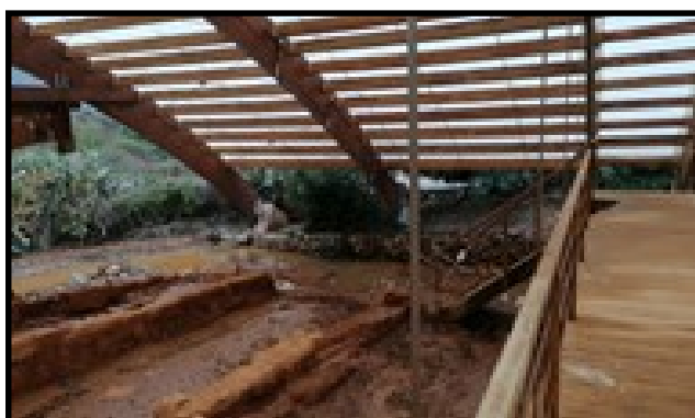
Εικόνα 10.61. Αποτύπωμα πλημμύρας στην ευρύτερη περιοχή των στεγάστρων προφύλαξης του Αρχαιολογικού Χώρου Μαλίων
